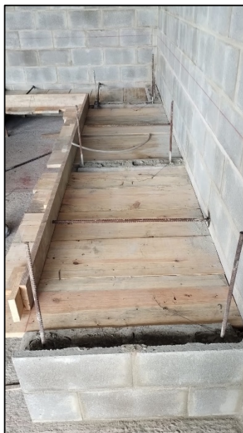
Fotografía 202. Construcción de mesones en concreto reforzado en el hangar del taller de maquinaria (izquierda) y Nivelación y replanteo para la construcción de andenes perimetrales al área del hangar del taller de maquinaria (derecha)
