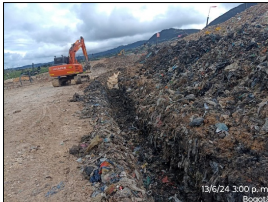
Fotografía 151. Construcción de filtro en piedra rajón de 10” y geotextil no tejido de 119 gr/m2 para corrección de brote de lixiviados en la terraza 1
