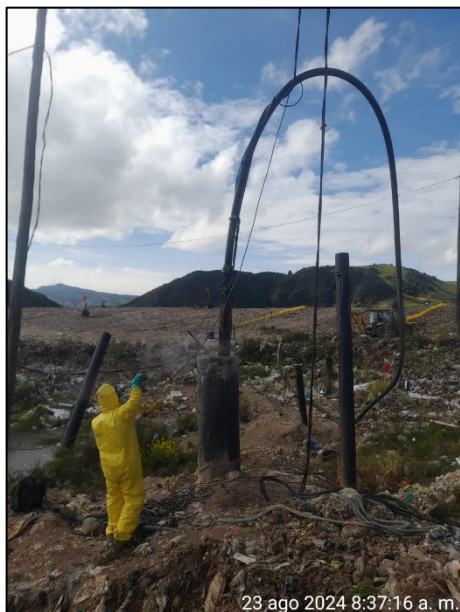
Fotografía 139. Mantenimiento y limpieza de bomba sumergible - Ferrari
