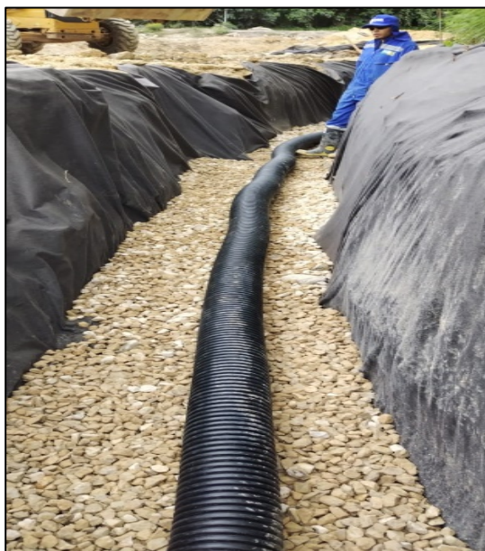
Fotografía 56. Construcción de subdrén entre las abscisas K2+240 y K2+270 - costado derecho
