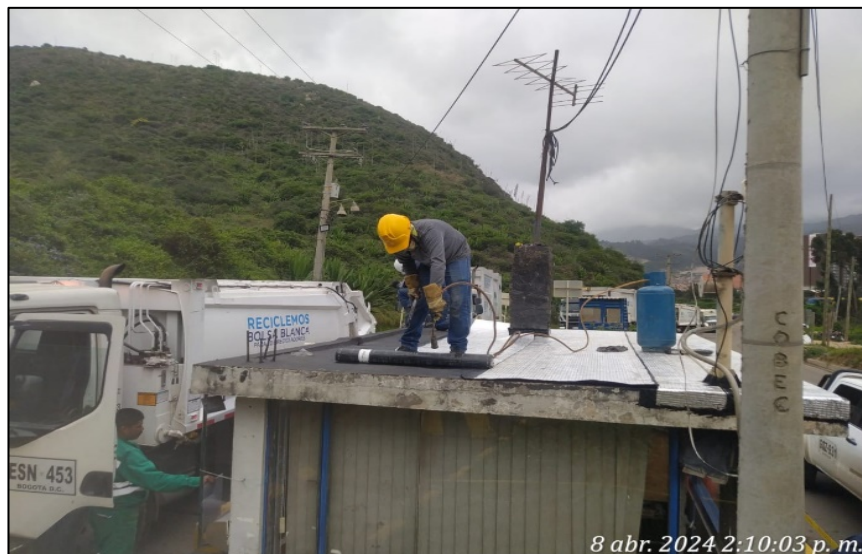
Fotografía 79. Instalación de manto asfáltico para impermeabilización de cubierta de la caseta de la báscula de entrada (izquierda) y cambio de tanque elevado de 5000 lt a 10000 lt para el campamento de Zona VIII y aumentar de esta forma la capacidad de reserva de agua (derecha)
