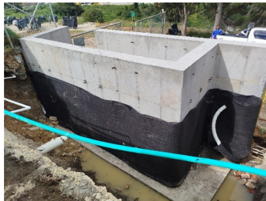
Fotografía 217. Vaciado de concreto, retiro de formaleta e instalación de geodrén para construcción de muro de contención – Sección No. 6 - PTL.
