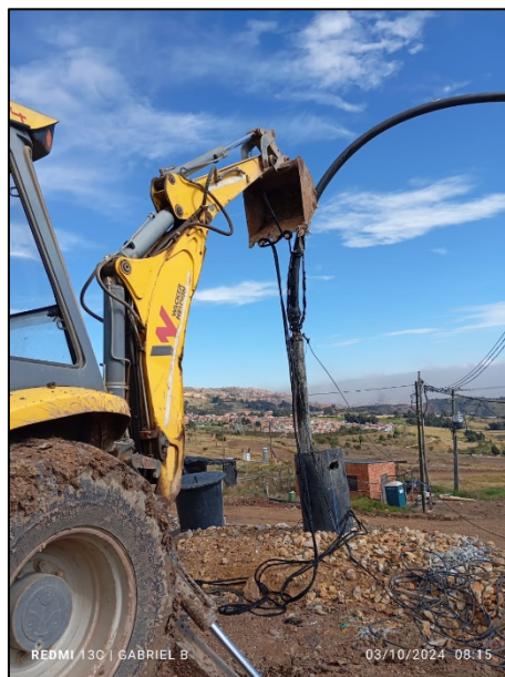
Fotografía 143. Mantenimiento y limpieza a bomba de extracción forzada de lixiviado – Pozo 4 (izquierda) y CHP 1074 (Derecha)
