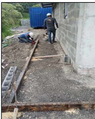
Fotografía 226. Construcción de andén perimetral
