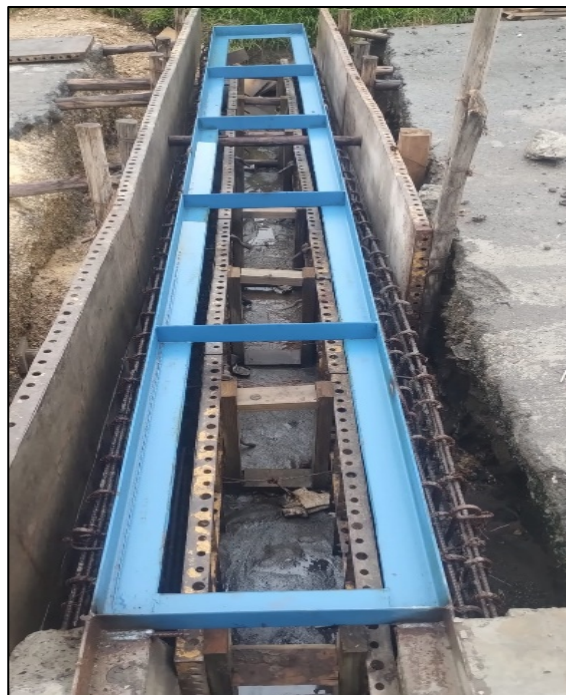
Fotografía 69. Construcción e instalación de marco para rejillas del cárcamo – Bascula de salida.
