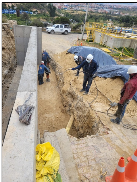
Fotografía 218. Relleno con material recebo B-200 en la sección No. 3 del muro de contención – PTL (izquierda) y Armado de acero de refuerzo para la construcción de la sección No. 4 del muro de contención – PTL (derecha)
