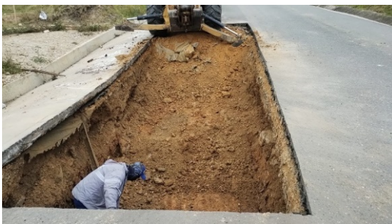
Fotografía 61. Excavación para arreglo de fallo ubicado en el carril de salida de la abscisa K1+330 (izquierda) y Compactación de base granular en reparación de pavimento en calidad de garantía sobre la abscisa K1+330 (derecha)
