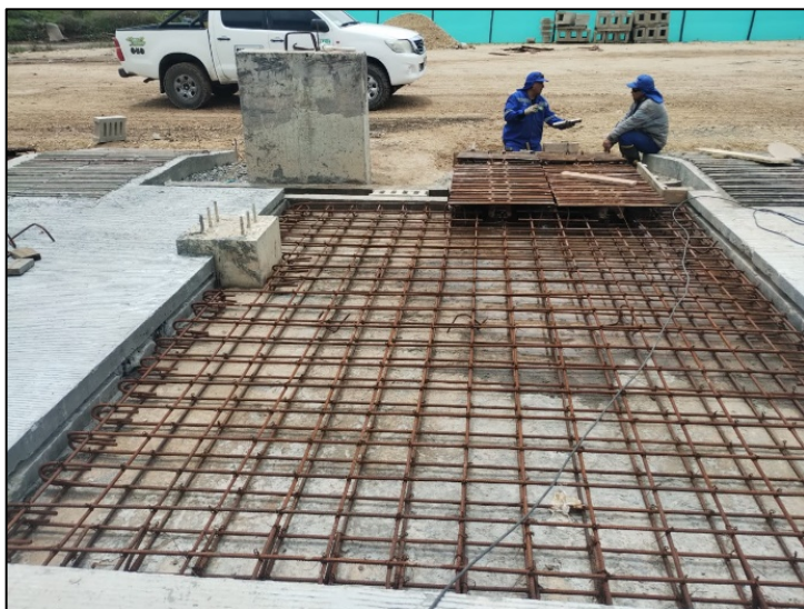
Fotografía 193. Fundida en concreto reforzado de placa de cimentación y rampas de acceso
