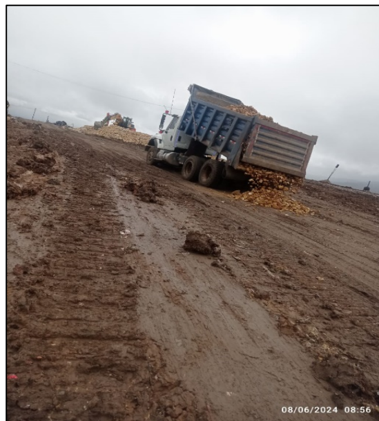
Fotografía 20. Refuerzo de capa de rodadura con material triturado en piedra rajón de 4" a 6" en circuito de ingreso y salida del frente de descargue.
