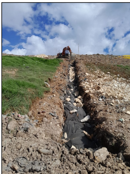
Fotografía 172. Adecuación de filtros de cierre - Zona de Optimización Fase I.
