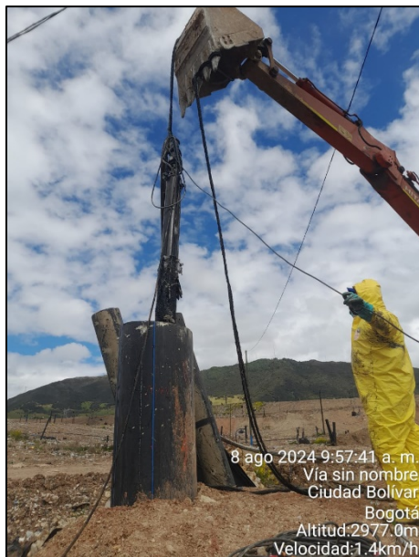
Fotografía 140. Limpieza de pozo CH 1070 e instalación de bomba sumergible tipo (izquierda) y Mantenimiento y limpieza de bomba sumergible – terraza 3ª (derecha) y Pozo 5 (derecha)
