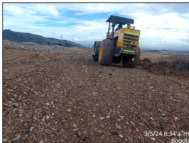
Fotografía 17. Refuerzo de capa de rodadura con material triturado reciclado en circuito de ingreso y salida del frente de descargue.
