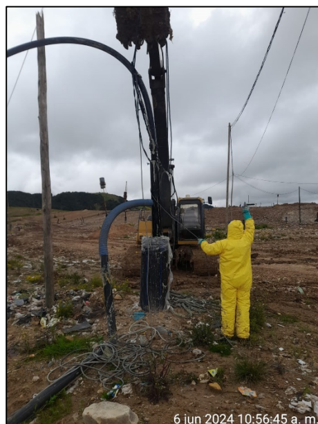
Fotografía 137. Mantenimiento y limpieza de bomba sumergible – Pozo 5
