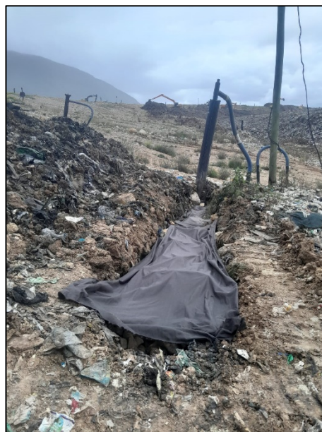
Fotografía 150. Construcción de filtro en piedra rajón de 10" y geotextil no tejido de 119 gr/m2 para corrección de brote de lixiviados en la terraza 1
