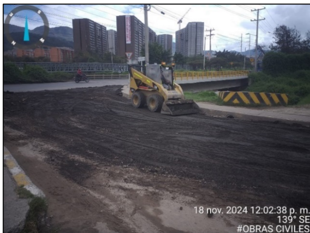
Fotografía 30. Mantenimiento y refuerzo capa de rodadura con material fresado – Portería Principal (izquierda) y refuerzo de capa de rodadura con aplicación de agregado reciclado – Vía alterna sector Zona IV (derecha)
