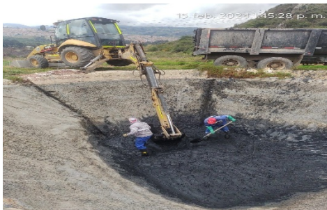
Mantenimiento de desarenador de pondajes 2
