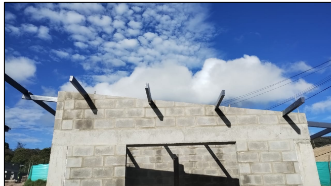
Fotografía 200. Construcción de mampostería y viga estructural perteneciente al cuarto de motores, bodega de repuestos y cuarto de aceites usados (izquierda) e Instalación de la perfilaría metálica para la cubierta – cuarto de aceites (derecha)
