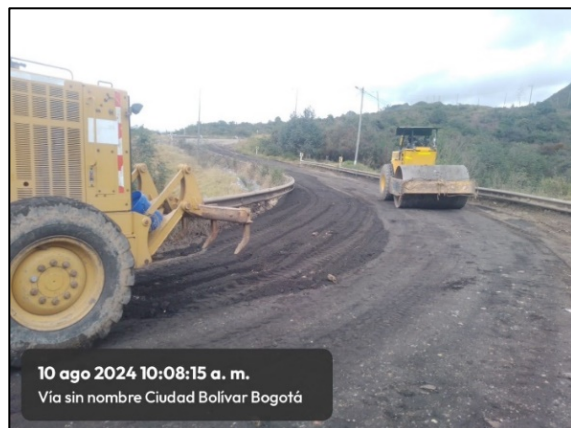
Fotografía 24. Mantenimiento a capa de rodadura perteneciente a la vía alterna – zona 4.
