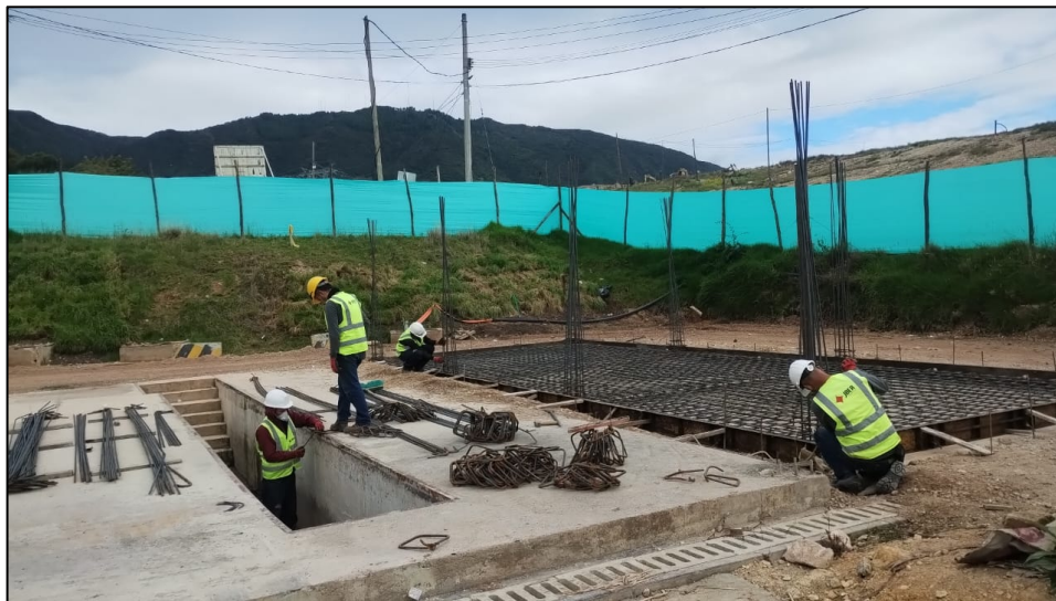
Fotografía 195. Amarre de acero para la construcción de placa de cimentación perteneciente al cuarto de aceites de nuevo taller
