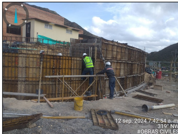
Fotografía 219. Figurado y armado del acero de las secciones 4 y 5 del muro de contención – PTL (izquierda) y formateado y fundida en concreto – Sección No. 4 y 5 del muro de contención - PTL (derecha)
