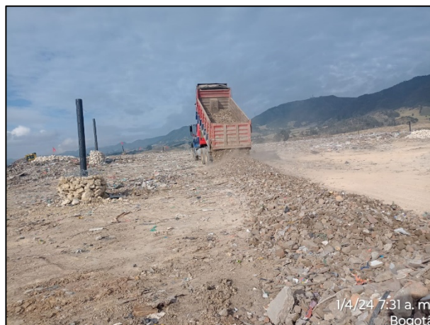
Fotografía 16. Refuerzo de capa de rodadura con material triturado en piedra rajón de 4" a 6" (izquierda) y agregado reciclado (derecha) en circuito de ingreso y salida del frente de descargue.
