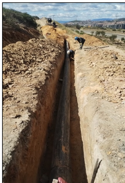
Fotografía 213. Lleno y compactación de espacios entre el talud y canal aguas lluvias (Izquierda) e Instalación de tubería PEAD de 14" para el descoles (derecha) de las estructuras de drenaje de aguas lluvias – talud Poste 53.
