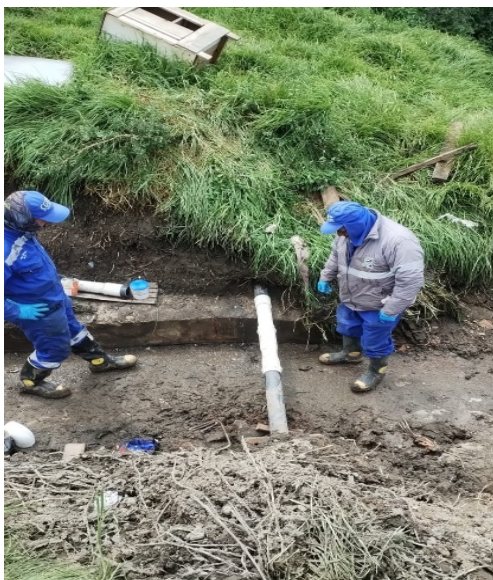
Fotografía 88. Reparación de fuga de acometida intradomiciliar de acueducto (izquierda) e instalación de reflector con panel solar en contenedor del frente de disposición (derecha)
