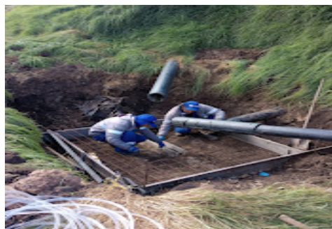
Construcción de nuevas cajas
