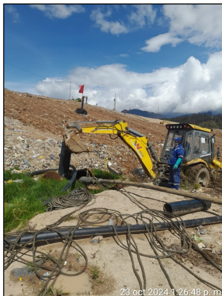
Fotografía 142. Mantenimiento y limpieza a bomba de extracción forzada de lixiviado – terraza 4 (izquierda) y realce de tubería de encamisado del pozo lateral 3B (derecha)
