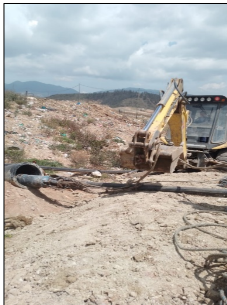
Fotografía 131. Mantenimiento y limpieza de bomba sumergible marca Franklin Electric 7.5 hp – Pozo lateral de terraza 2
