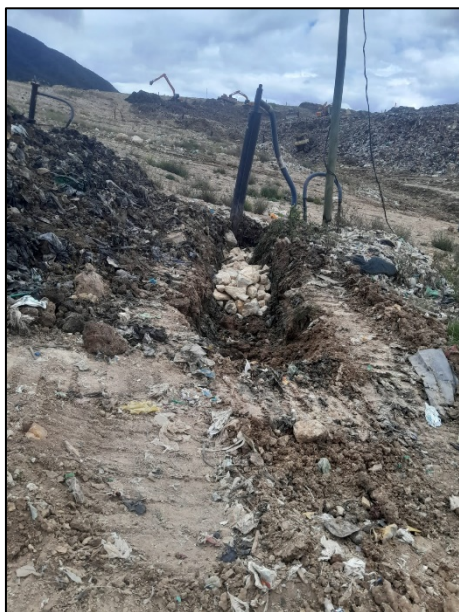
Fotografía 150. Construcción de filtro en piedra rajón de 10" y geotextil no tejido de 119 gr/m2 para corrección de brote de lixiviados en la terraza 1
