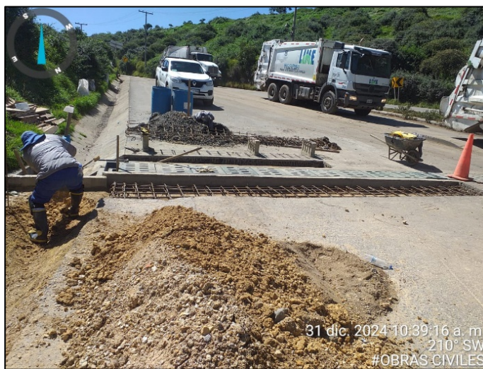
Fotografía 70. Construcción placa en concreto reforzado para acceso al cárcamo.
