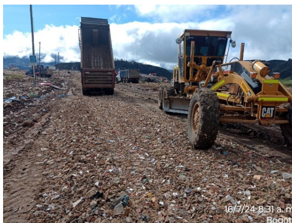
Fotografía 21. Mantenimiento y refuerzo de capa de rodadura con triturado en piedra rajón de 4" a 6" y agregado seleccionado en vía de ingreso al frente de disposición.
