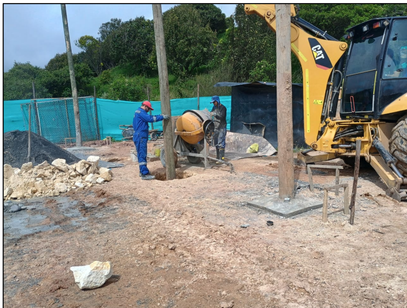
Fotografía 194. Nivelación de rasante con recebo (Izquierda) e instalación de columnas con postes de madera inmunizados para hangar adicional de mantenimiento (derecha)
