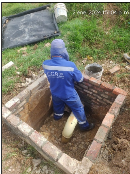
Fotografía 72. Mantenimiento a cajas de lixiviados ubicadas en Zona I Área 2.
