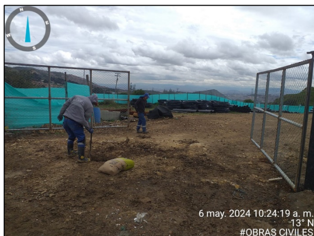
Fotografía 83. Instalación de puerta en tubería galvanizada y malla eslabonada para acceso al acopio de tuberías (izquierda) y mantenimiento de plataforma de taller temporal de Zona VII con material triturado de 4" a 6" (derecha)
