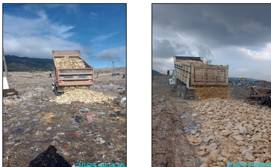
Fotografía 11. Mantenimiento circuito de entrada y salida de frente de disposición- terraza 2 de la zona de Optimización Fase II.
