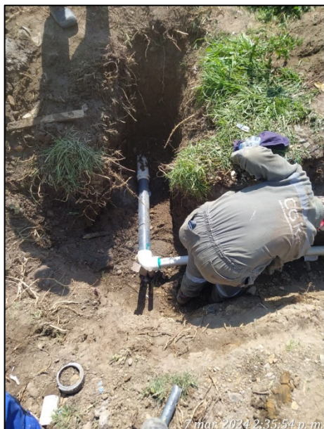
Fotografía 76. Arreglo de fuga en acometida principal del acueducto – Avenida Boyacá
