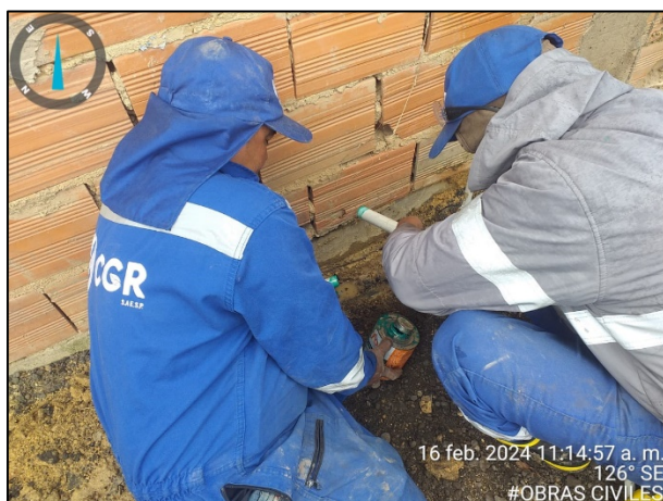
Fotografía 73. Instalación de sistema de presurización de suministro de agua la red hidráulica de la batería de baños y la cocineta ubicados en el campamento de Zona VIII.
