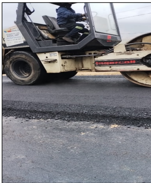
Fotografía 58. Compactación de capa de rodadura entre las abscisas K2+210 y K2+260
