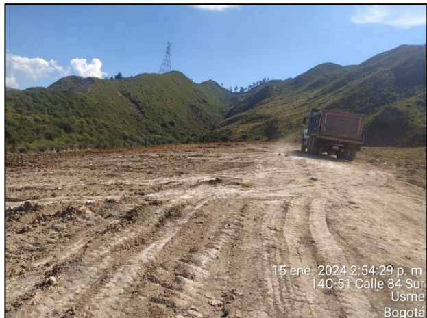
Fotografía 181. Instalación de arcilla en cierre de Zona II - Área 3
