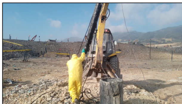
Fotografía 134. Mantenimiento y limpieza de bomba sumergible marca Franklin Electric de 20 hp – Pozo 1
