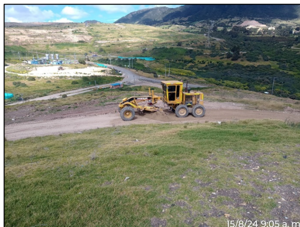
Fotografía 174. Culminación prueba de instalación de material proveniente del proceso de RCD's y RPCC's como recebo en bermas de Biosólidos dentro del proceso de cierre definitivo
