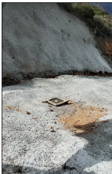
Fotografía 207. Instalación de mojones de topografía en talud poste "53"
