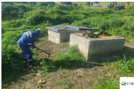
Arreglo perimetral de caja conducción
