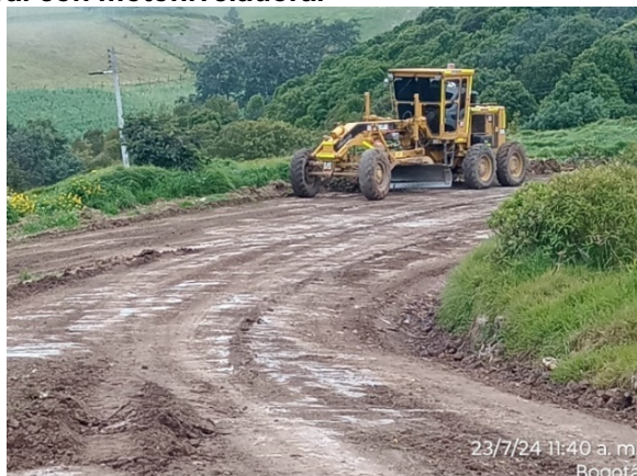
Fotografía 22. Mantenimiento circuito de entrada y salida de frente de disposición- terraza 2 y vía acopio 1-taller temporal con motoniveladora.
