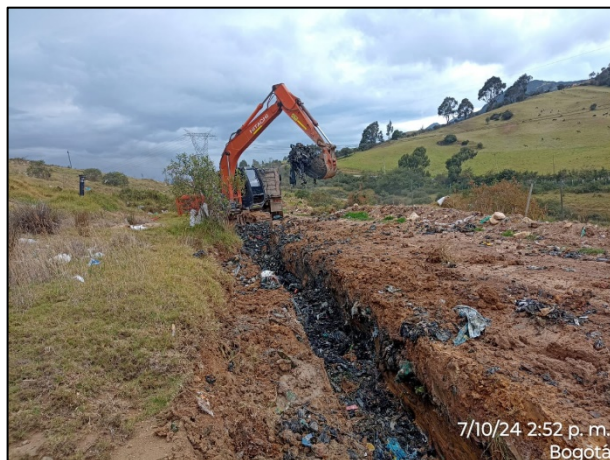
Fotografía 170. Adecuación de filtros de cierre - Zona de Optimización Fase I.
