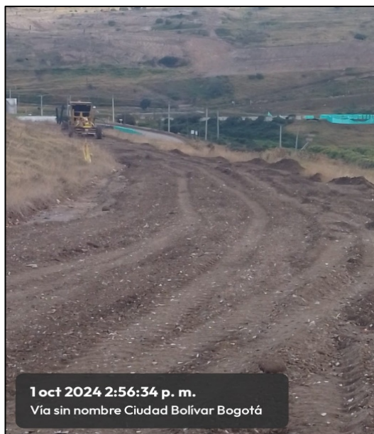
Fotografía 176. Instalación de material proveniente del proceso de RCD's y RPCC's como recebo en bermas de Biosólidos dentro del proceso de cierre definitivo
