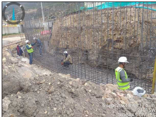
Fotografía 219. Figurado y armado del acero de las secciones 4 y 5 del muro de contención – PTL (izquierda) y formateado y fundida en concreto – Sección No. 4 y 5 del muro de contención - PTL (derecha)
