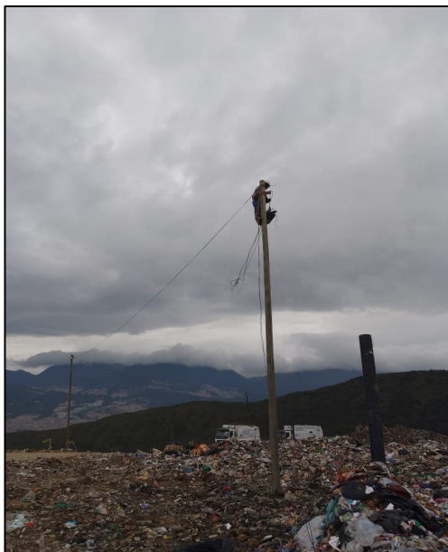
Fotografía 106. Traslado de redes eléctricas de iluminación según avances de la secuencia de llenado
