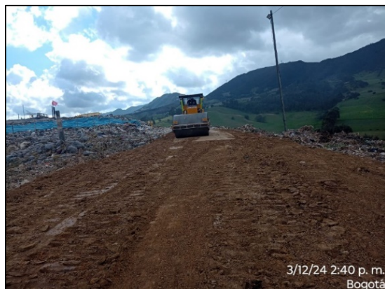
Fotografía 31. Adecuacion de via para accezo a zona 8 – Frente de disposición (izquierda) y mantenimiento a capa de rodadura en vías operativas con triturado de 4" a 6" – Frente de disposicion (derecha)
