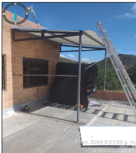
Fotografía 93. Instalación de estructura para cubierta de equipo de laboratorio – Edificio principal PTL (izquierda) y reparación de tejas de cubierta del campamento de la interventoría (derecha)
