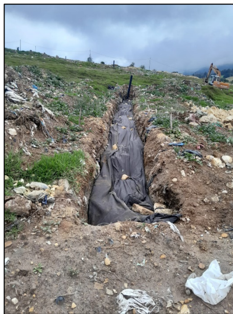
Fotografía 165. Adecuación de filtros geotextil de 119 gr/m2 y piedra rajón del 10" - filtros de cierre Zona de Optimización Fase I
