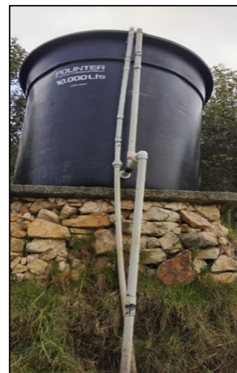
Fotografía 79. Instalación de manto asfáltico para impermeabilización de cubierta de la caseta de la báscula de entrada (izquierda) y cambio de tanque elevado de 5000 lt a 10000 lt para el campamento de Zona VIII y aumentar de esta forma la capacidad de reserva de agua (derecha)
