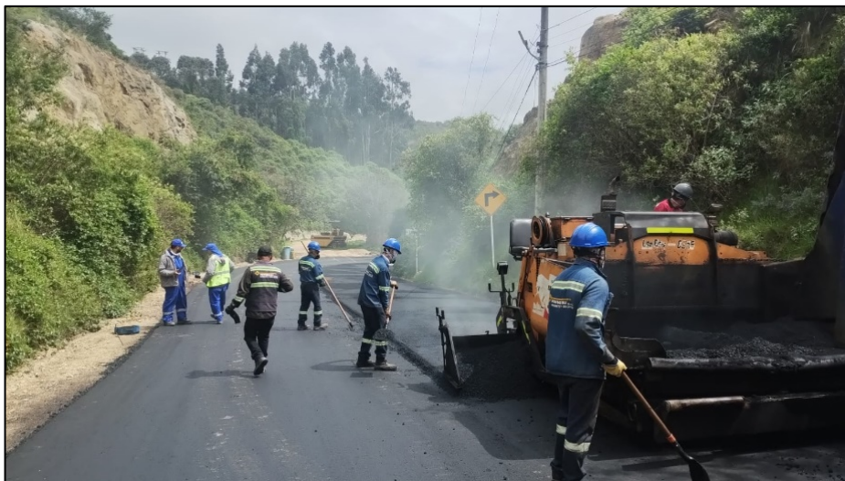
Fotografía 60. Extendido de capa de rodadura entre las abscisas K2+315 y K2+460 en ambos carriles y desde el K2+460 al K2+480 en el costado derecho.
