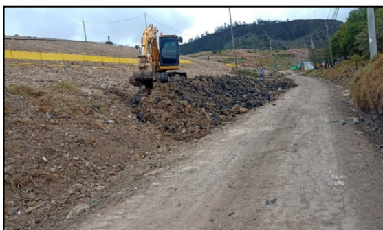
Fotografía 152. Corrección de brote lixiviado 48. – Frente a zona de corte y pegue de tubería (izquierda) y Corrección de brote lixiviado 62 – Ferrari (derecha)
