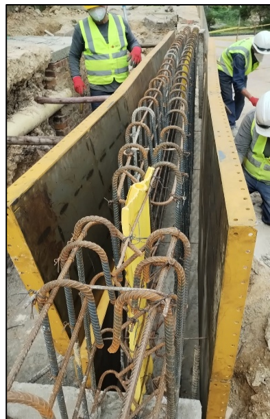
Fotografía 215. Armado de formaleta metálica para construcción de muro de construcción PTL
