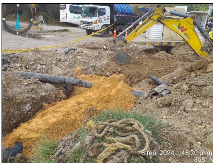
Fotografía 35. Instalación de tubería PEAD de 14" como pasante de conducción de aguas lluvias frente del campamento principal
