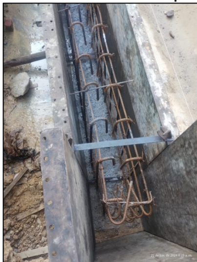
Fotografía 216. Vaciado de concreto para construcción de muro de contención - PTL
