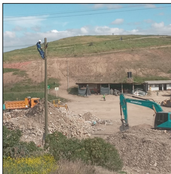
Fotografía 119. Instalación de poste en concreto para acometida del nuevo taller (izquierda) e instalación de nuevo circuito eléctrico para refuerzo de iluminación – Mixtos (derecha)
