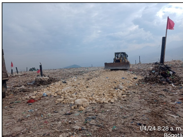
Fotografía 16. Refuerzo de capa de rodadura con material triturado en piedra rajón de 4" a 6" (izquierda) y agregado reciclado (derecha) en circuito de ingreso y salida del frente de descargue.
