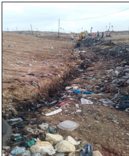
Fotografía 153. Construcción de filtro en piedra rajón de 10" y geotextil no tejido de 119 gr/m2 para corrección de brote de lixiviados en la terraza 1
