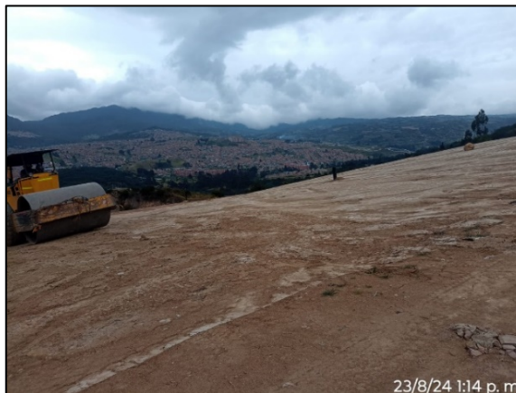
Fotografía 187. Compactación de complemento de capa de arcilla en Zona II - Área 3.
