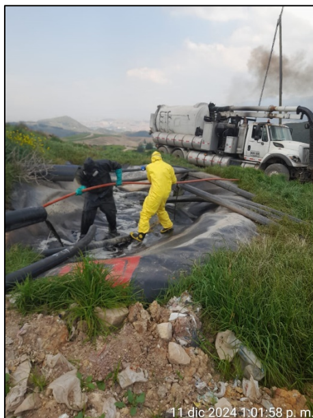
Fotografía 145. Limpieza y mantenimiento bomba de extracción forzada pozo 2 (izquierda) y limpieza de mangueras conductoras de lixiviado con vector (derecha)
