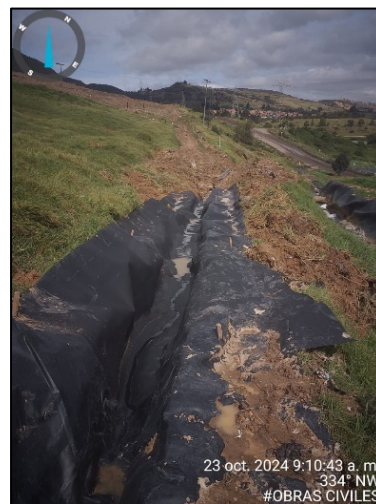
Fotografía 45. Mantenimiento y limpieza de canal de aguas lluvias en concreto ubicada entre SBR y Campamento principal (izquierda) y Mantenimiento y limpieza de cuneta en geomembrana – Optimización Fase 1 (derecha)
