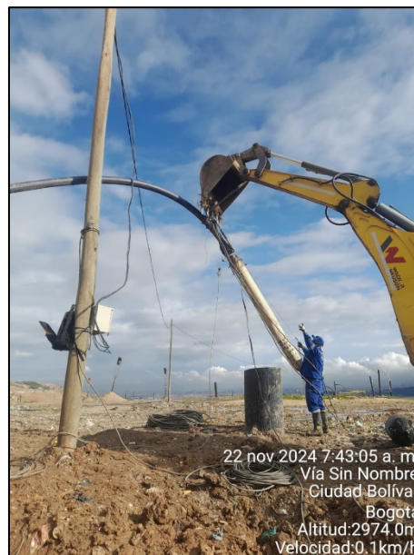
Fotografía 144. Mantenimiento y limpieza a bomba de extracción forzada de lixiviado – Subdrén terraza 2 (izquierda) y chimenea perforada 1063 (derecha)
