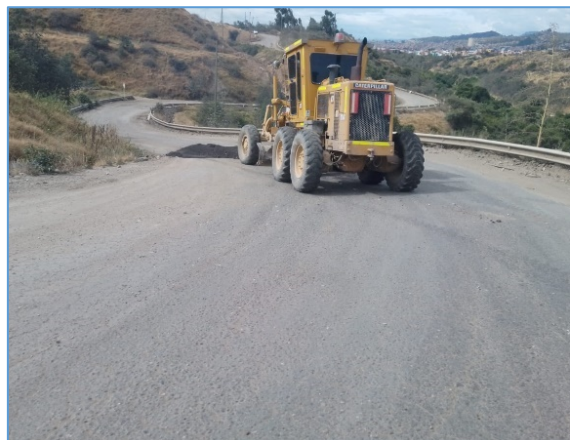
Fotografía 25. Refuerzo de capa de rodadura con aplicación de agregado reciclado en circuito de ingreso y salida del frente de descargue (izquierda) y Mantenimiento a capa de rodadura perteneciente a la vía alterna – Zona 4 aplicando material fresado de carpeta asfáltica (derecha).
