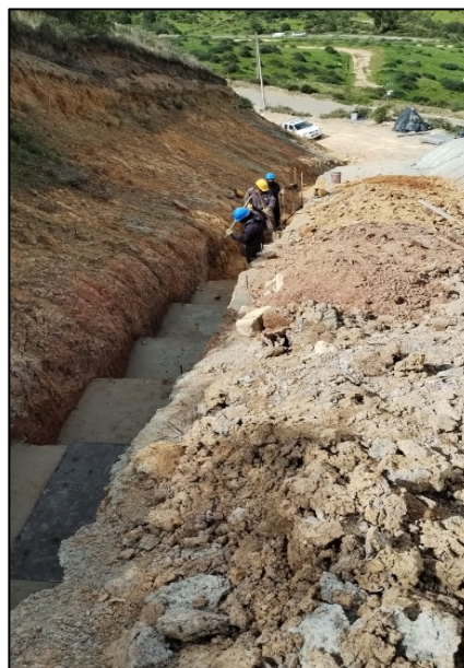
Fotografía 211. Construcción de disipadores de energía – Descenso de berma 3 a berma 2 - talud “Poste 53”
