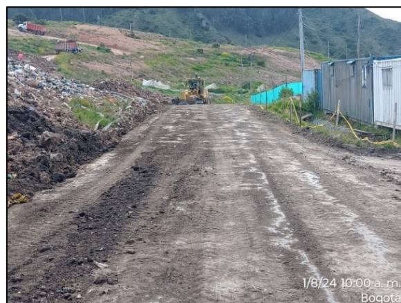
Fotografía 23. Mantenimiento y refuerzo de capa de rodadura con material triturado en piedra rajón de 4" a 6" en circuitos de disposición.
