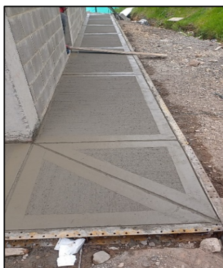
Fotografía 226. Construcción de andén perimetral
