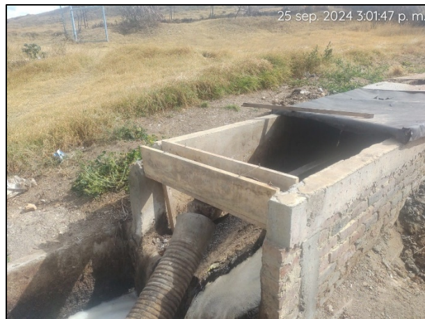
Fotografía 92. Reconstrucción de vigas transversales de refuerzo en canal de conducción principal de lixiviados (izquierda) y poda de pasto y limpieza en el área interna del campamento principal (derecha)
