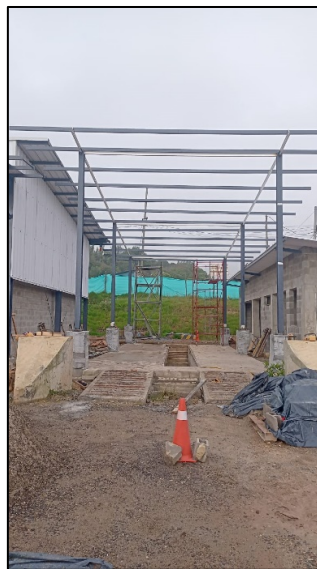
Fotografía 201. Construcción de ménsulas para soporte de estructura de acero – Cárcamo – Nuevo taller (izquierda) e instalación de pórtico en estructura metálica - Cárcamo Nuevo taller (derecha).
