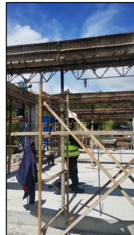
Fotografía 223. Instalación de formaleta metálica para vaciado de concreto de las vigas de amarre – Oficinas del nuevo taller y vestieres
