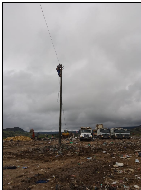
Fotografía 112. Traslado de redes eléctricas de iluminación según avances de la secuencia de llenado
