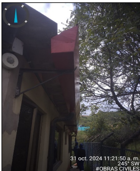
Fotografía 94. Reposición de canaletas metálicas de manejo de aguas lluvias de la cubierta del campamento de la Interventoría (izquierda) y de lixiviados sector – SBR (derecha)
