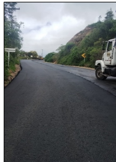
Fotografía 60. Extendido de capa de rodadura entre las abscisas K2+315 y K2+460 en ambos carriles y desde el K2+460 al K2+480 en el costado derecho.
