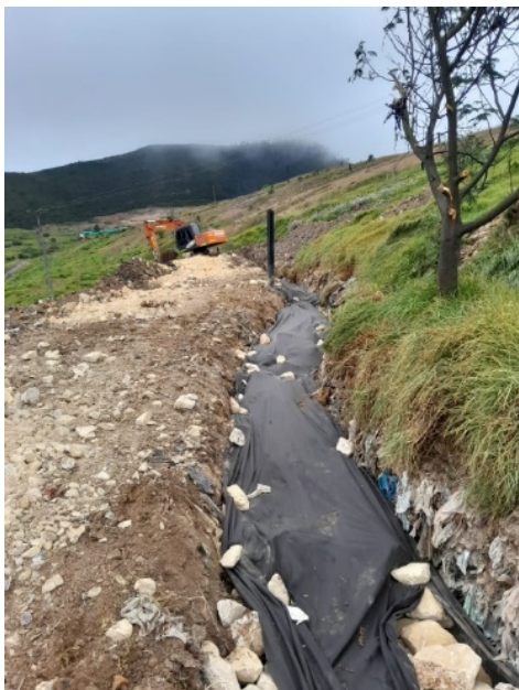
Fotografía 167. Adecuación de filtros de cierre - Zona de Optimización Fase I
