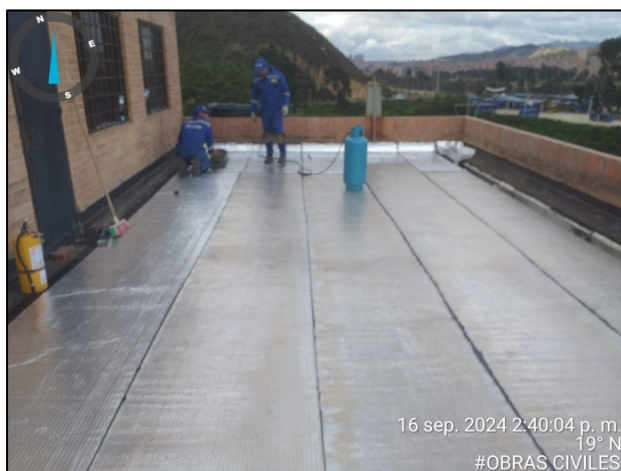
Fotografía 91. Impermeabilización con manto asfáltico en terraza del segundo nivel – Oficina principal PTL (izquierda) y Terminación de construcción de tanque de almacenamiento en concreto reforzado para aguas de escorrentías – Zona de reservorio (derecha)
