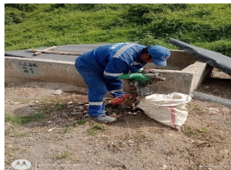
Limpieza de cajas
