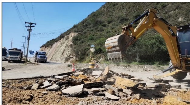
Fotografía 55. Demolición y retiro de la carpeta asfáltica existente entre las abscisas K2+440 y K2+460
