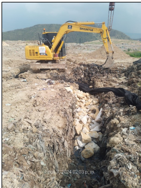
Fotografía 159. Atención brote de lixiviado ID 55 - Pata talud de plataforma VI. (izquierda) y Atención brote de lixiviado ID 68 - Empozamiento en el perímetro del ML 5, 4ª COL. 11. (derecha)
