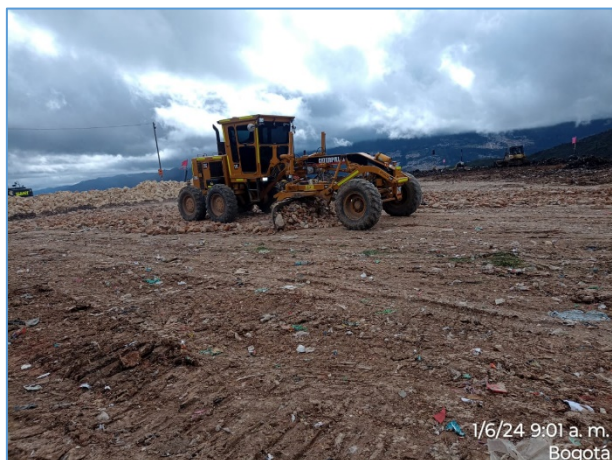
Fotografía 19. Refuerzo de capa de rodadura con agregado seleccionado en circuito de ingreso y salida del frente de descargue.
