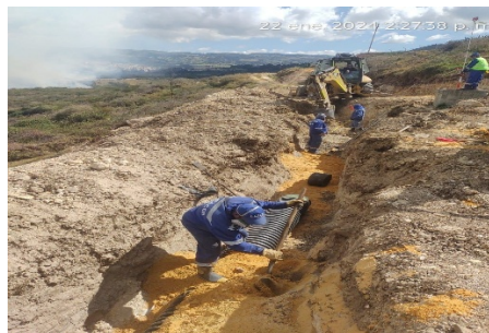
Cambio de geomembrana de los canales
