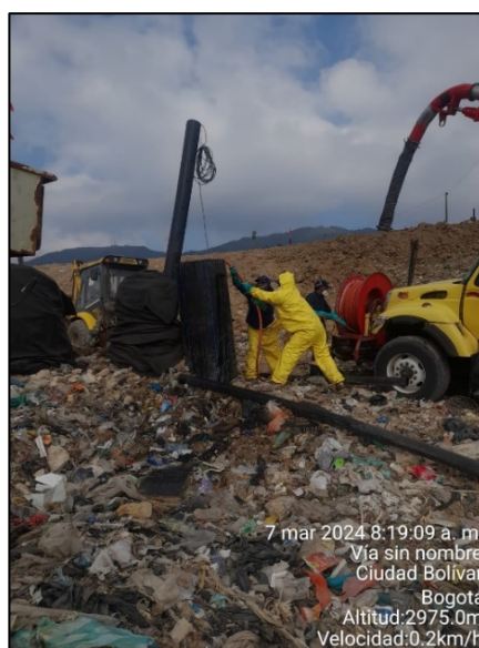
Fotografía 132. Mantenimiento y lavado de con equipo vector de succión - presión a tubería de extracción forzada perteneciente al Pozo 2
