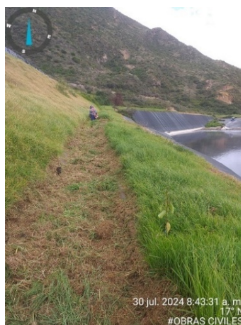
Fotografía 41. Limpieza de canales de aguas lluvias correspondientes a bermas del talud de Poste 53 (izquierda) y poda de pasto perimetral de cunetas revestidas en geomembrana en el sector de Celda VI (derecha)
