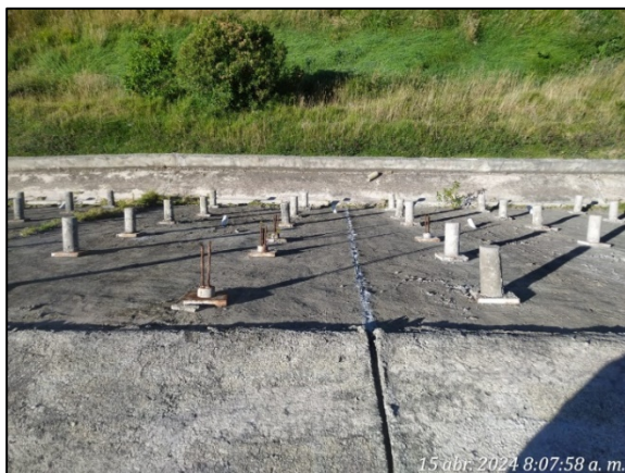
Fotografía 81. Reconstrucción de botones para protección de guaya expuesta – Dique VI (izquierda) y cambio de lavaplatos – Laboratorio PTL (derecha)
