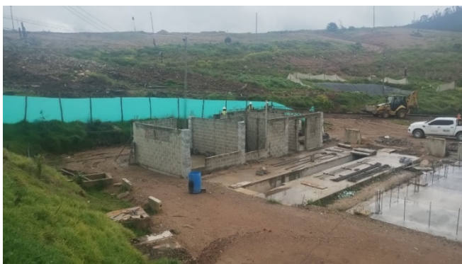
Fotografía 196. Levantes en mampostería para la construcción del cuarto de aceites, cuarto de motores y de repuestos del nuevo taller de maquinaria
