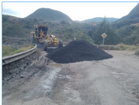
Fotografía 26. Refuerzo de capa de rodadura con material triturado en piedra rajón de 4” a 6” en circuito de ingreso y salida del frente de descargue (izquierda) y Mantenimiento a capa de rodadura perteneciente a la vía alterna – Zona 4 aplicando material fresado de carpeta asfáltica (derecha).
