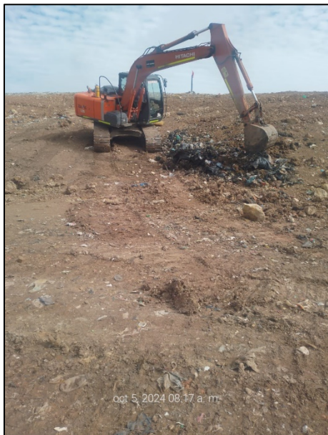
Fotografía 155. Inicio de excavación para atención de brote nuevo – Terraza III. (izquierda) y atención brote de lixiviado ID 63 – Zona VII, caseta 1 (derecha)
