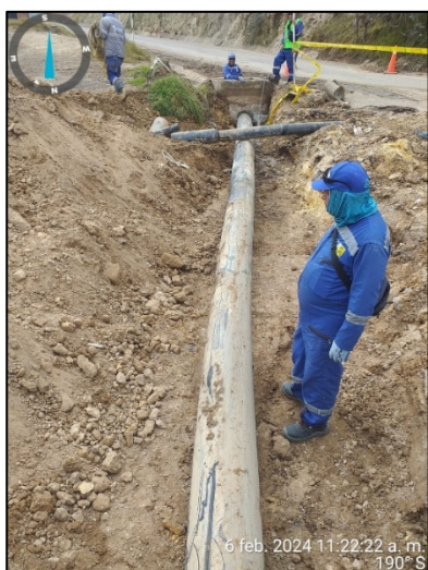
Fotografía 35. Instalación de tubería PEAD de 14" como pasante de conducción de aguas lluvias frente del campamento principal
