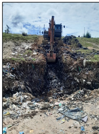
Fotografía 170. Adecuación de filtros de cierre - Zona de Optimización Fase I.
