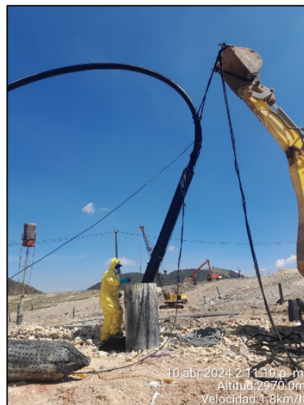
Fotografía 135. Instalación de pasante para mangueras de lixiviado en terraza 1 (Izquierda) y extracción de bomba sumergible para mantenimiento (derecha)
