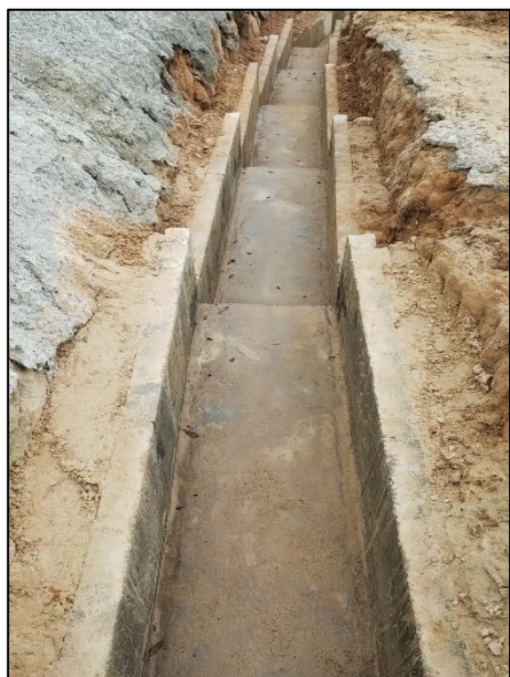
Fotografía 213. Lleno y compactación de espacios entre el talud y canal aguas lluvias (Izquierda) e Instalación de tubería PEAD de 14" para el descoles (derecha) de las estructuras de drenaje de aguas lluvias – talud Poste 53.
