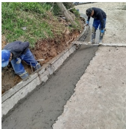
Fotografía 62. Fundida en concreto para construcción de cunetas perimetrales en el tramo entre las abscisas K2+200 y K2+480- costado derecho (izquierda) y construcción de poceta en concreto reforzado para recolección de aguas lluvias de las cunetas y entrega a la red en tubería corrugada de 15" de diámetro que entrega su caudal a los descoles de la vía principal en el sector de la portería principal – K0+110 costado derecho (Derecha)
