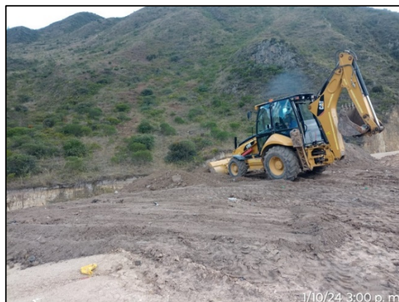
Fotografía 189. Instalación de capa tierra negra en Zona II – Área 3.
