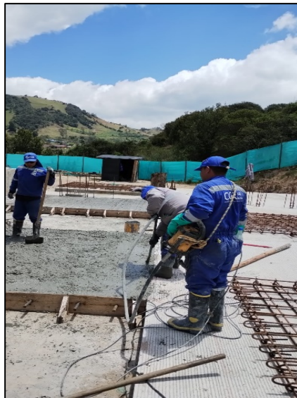
Fotografía 192. Fundida en concreto reforzado de placa de cimentación y rampas de acceso
