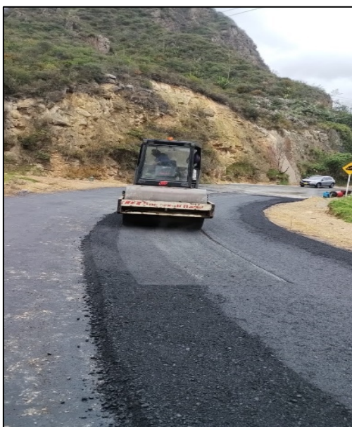
Fotografía 58. Compactación de capa de rodadura entre las abscisas K2+210 y K2+260
