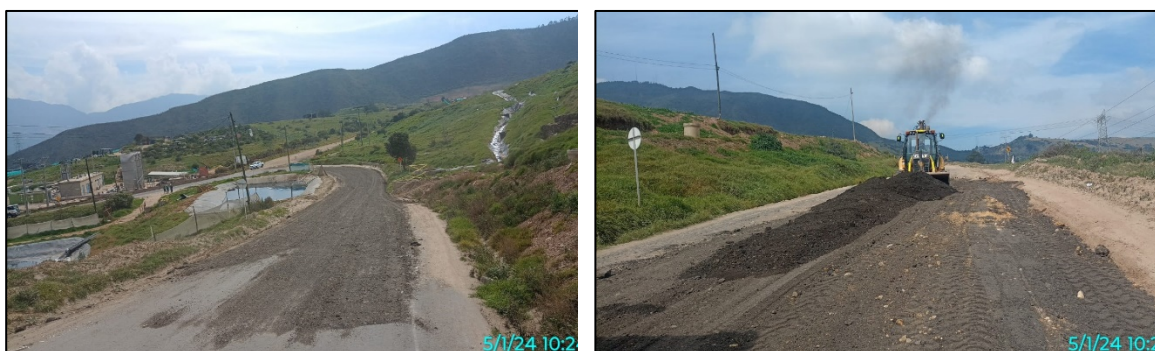
Fotografía 10. Aplicación de material fresado de carpeta asfáltica sobre la vía principal – sector de la portería Boyacá y vía alterna por el sector de Zona 4.
