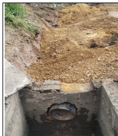
Fotografía 68. Construcción de dos reductores de velocidad en el sector aledaño al campamento principal (Izquierda) e Instalación de tubería de descole perteneciente al cárcamo de aguas lluvias - Basculas de salida (derecha)
