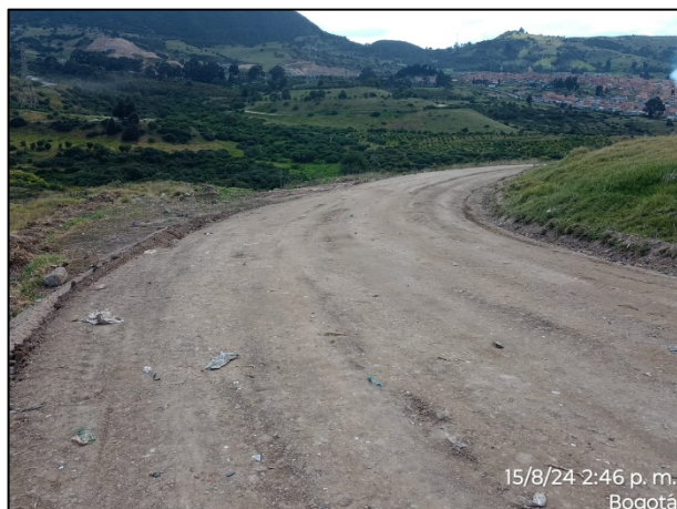
Fotografía 174. Culminación prueba de instalación de material proveniente del proceso de RCD's y RPCC's como recebo en bermas de Biosólidos dentro del proceso de cierre definitivo
