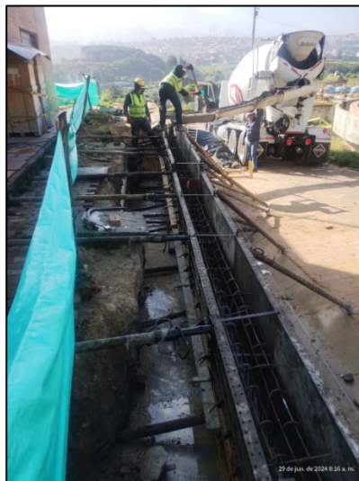
Fotografía 216. Vaciado de concreto para construcción de muro de contención - PTL
