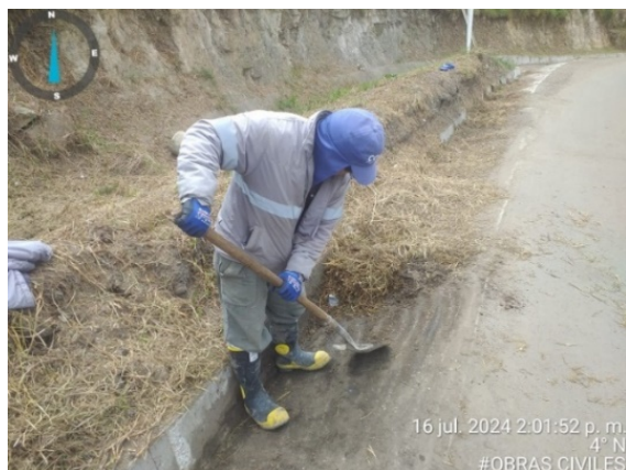
Fotografía 42. Retiro de pasto de poda de las cunetas perimetrales de la vía principal (izquierda) y Poda de pasto perimetral en cunetas correspondiente a la vía de acceso a la PTL (derecha).
