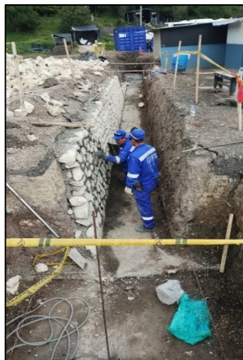
Fotografía 222. Construcción de canal de aguas lluvias en piedra pegada dentro del nuevo campamento de Fase II. (Izquierda) y fundida en concreto reforzado de placa de piso de zona de vestieres (ambiental y taller), oficina – taller y cuarto de insumos químicos (Derecha)
