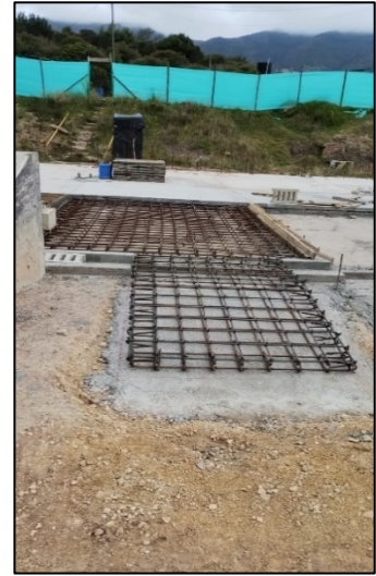
Fotografía 191. Figurado y armado de acero para rampas de acceso.
