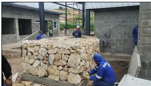
Fotografía 204. Construcción de gaviones con placa en concreto reforzado para instalación de tanque de almacenamiento elevado (Izquierda) y Construcción de vigas de amarre y placa cubierta en el cuarto eléctrico y compresores (Izquierda)
