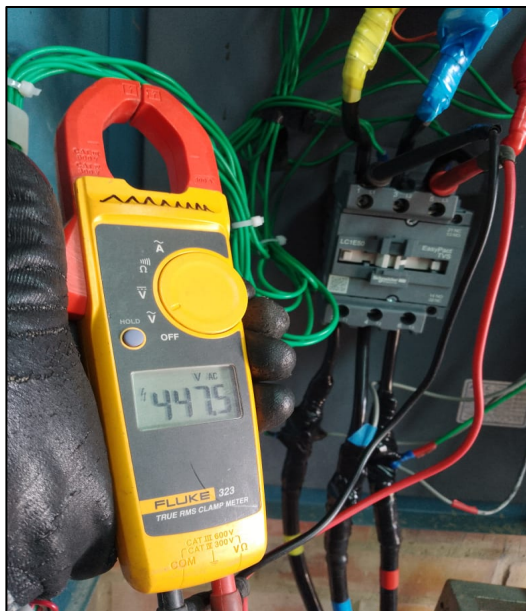
Fotografía 104. Revisión y corrección en fallas del circuito eléctrico en las instalaciones de campamento principal
