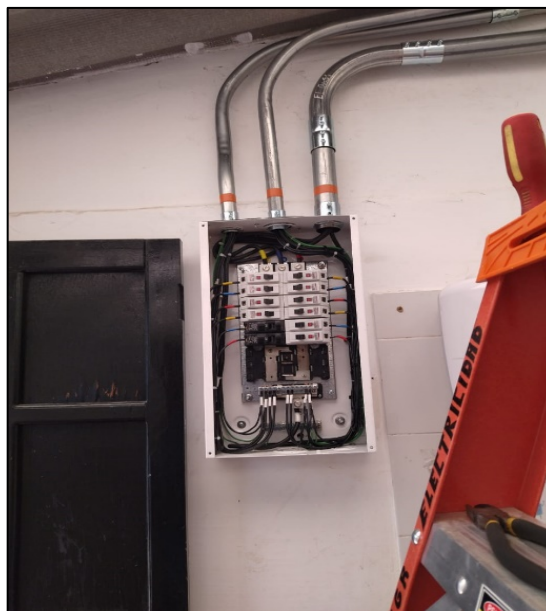
Fotografía 103. Cambio de acometida del circuito eléctrico de monofásico a trifásico – campamento cancha
