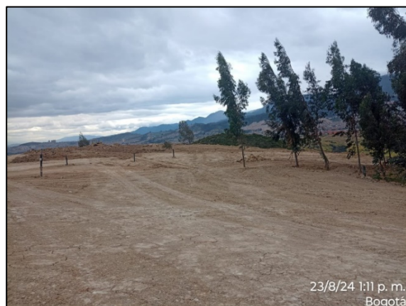
Fotografía 179. Instalación y compactación de complemento de capa de arcilla en Zona II - Área 2
