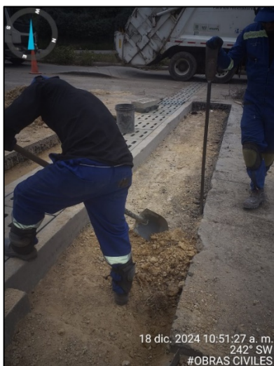
Fotografía 70. Construcción placa en concreto reforzado para acceso al cárcamo.
