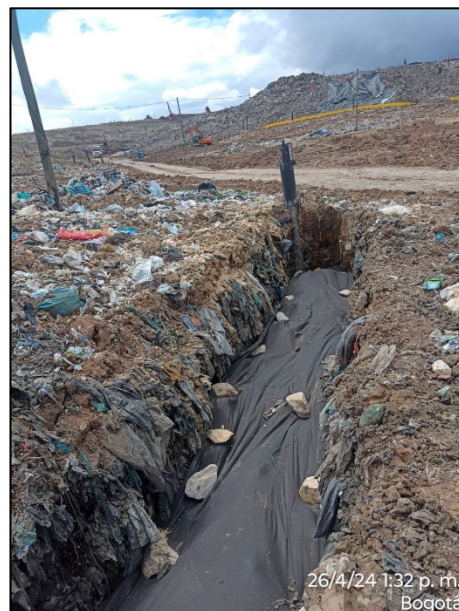
Fotografía 149. Construcción de filtro en piedra rajón de 10" y geotextil no tejido de 119 gr/m2 para corrección de brote de lixiviados en la terraza 1
