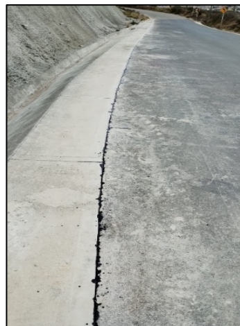
Fotografía 52. Construcción de reductores de velocidad en la báscula de salida (izquierda) y sellado de juntas de dilatación, fisuras y grietas sobre la rasante de la vía principal (derecha)
