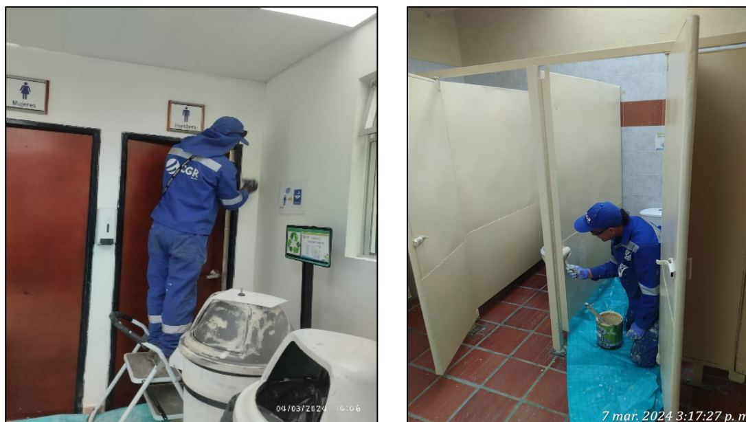
Fotografía 75. Trabajos de resane y pintura en zona de recepción, sala de juntas y otras oficinas del campamento principal (izquierda) y Pintura de divisiones metálicas en unidades sanitarias del vestidor de hombres- campamento principal (derecha)
