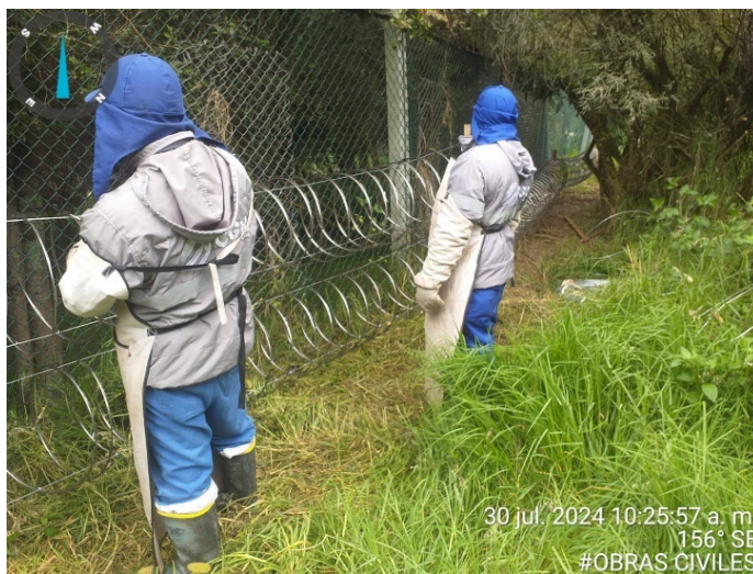
Fotografía 126. Instalación de concertina en cerramiento perimetral del tramo del dique VI
