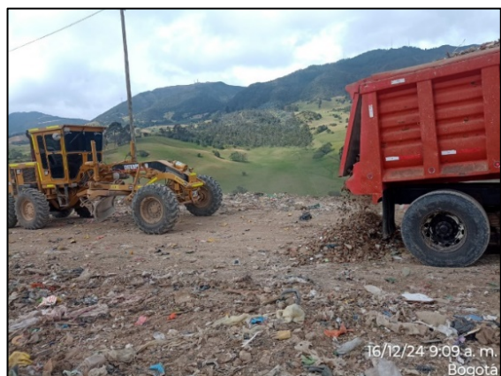
Fotografía 32. Mantenimiento a capa de rodadura en vías operativas con triturado de 4” a 6” y RPCC – Frente de disposición.
