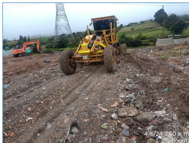
Fotografía 19. Refuerzo de capa de rodadura con agregado seleccionado en circuito de ingreso y salida del frente de descargue.
