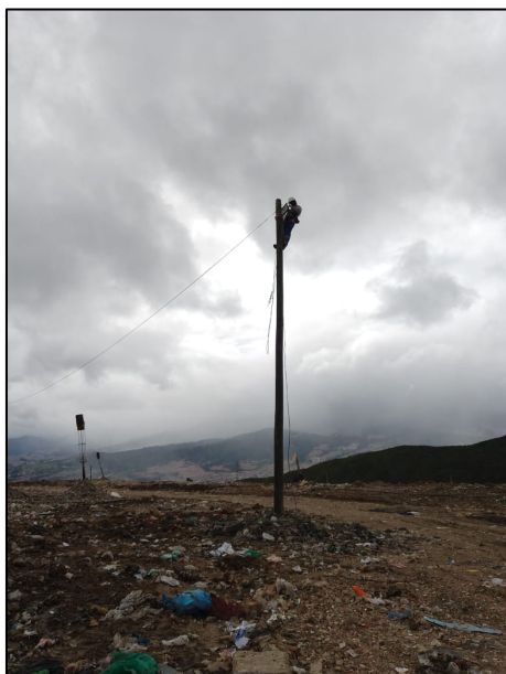
Fotografía 112. Traslado de redes eléctricas de iluminación según avances de la secuencia de llenado
