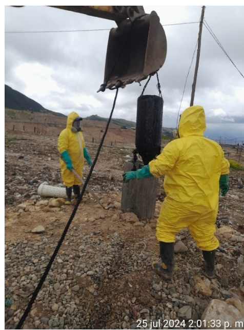
Fotografía 138. Reinstalación de bomba sumergible – Pozo de terraza 3B (Izquierda) y Limpieza de pozo CH 1070 como preparación para instalación de bomba sumergible (Derecha)
