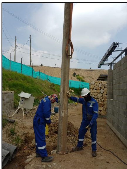
Fotografía 119. Instalación de poste en concreto para acometida del nuevo taller (izquierda) e instalación de nuevo circuito eléctrico para refuerzo de iluminación – Mixtos (derecha)
