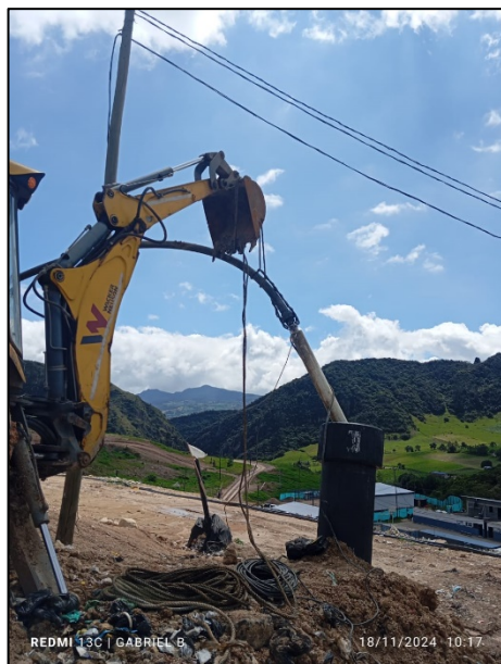
Fotografía 144. Mantenimiento y limpieza a bomba de extracción forzada de lixiviado – Subdrén terraza 2 (izquierda) y chimenea perforada 1063 (derecha)
