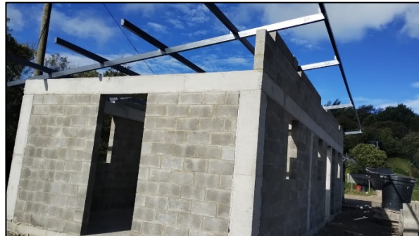
Fotografía 224. Construcción de mampostería en oficinas (izquierda) e instalación de perfilera metálica (derecha) para cubierta de taller, vestieres del área ambiental, taller, y cuarto de insumos químicos
