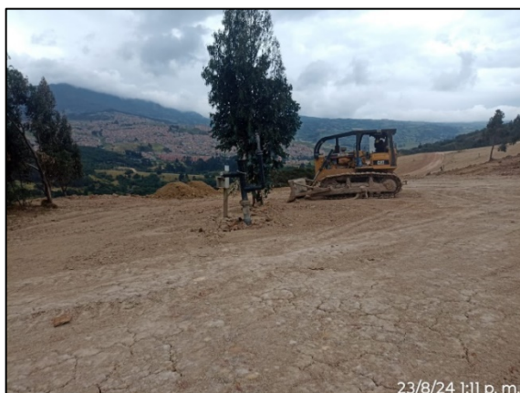
Fotografía 179. Instalación y compactación de complemento de capa de arcilla en Zona II - Área 2
