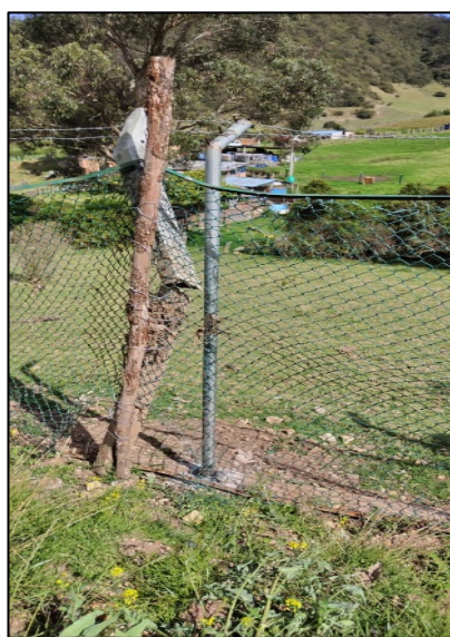
Fotografía 124. Instalación de postería en tubería galvanizada para reparación de tramos dañados del cerramiento perimetral
