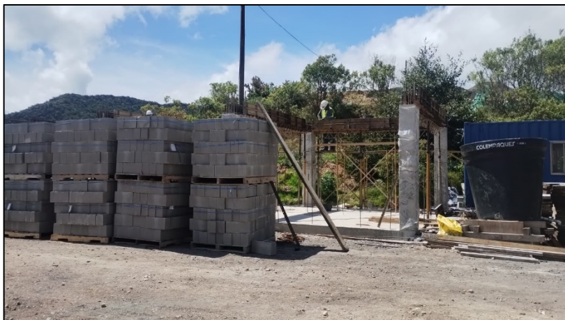
Fotografía 223. Instalación de formaleta metálica para vaciado de concreto de las vigas de amarre – Oficinas del nuevo taller y vestieres
