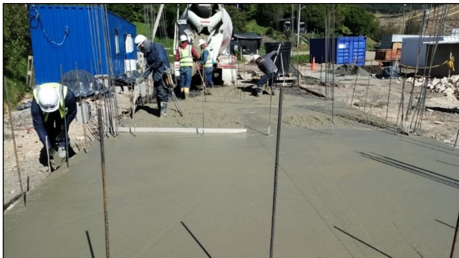
Fotografía 222. Construcción de canal de aguas lluvias en piedra pegada dentro del nuevo campamento de Fase II. (Izquierda) y fundida en concreto reforzado de placa de piso de zona de vestieres (ambiental y taller), oficina – taller y cuarto de insumos químicos (Derecha)
