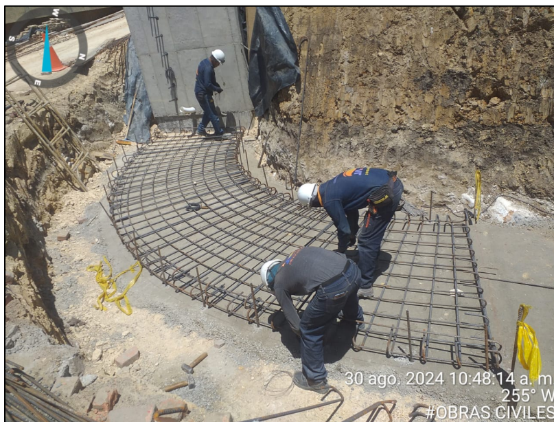
Fotografía 218. Relleno con material recebo B-200 en la sección No. 3 del muro de contención – PTL (izquierda) y Armado de acero de refuerzo para la construcción de la sección No. 4 del muro de contención – PTL (derecha)
