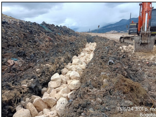
Fotografía 151. Construcción de filtro en piedra rajón de 10” y geotextil no tejido de 119 gr/m2 para corrección de brote de lixiviados en la terraza 1
