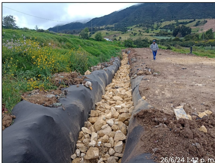
Fotografía 166. Adecuación de filtros geotextil de 119 gr/m2 y piedra rajón del 10" - filtros de cierre Zona de Optimización Fase I
