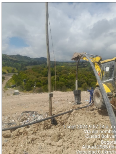
Fotografía 141. Mantenimiento y limpieza de bomba sumergible CHP 1035 (izquierda) y Pozo 1 (derecha)
