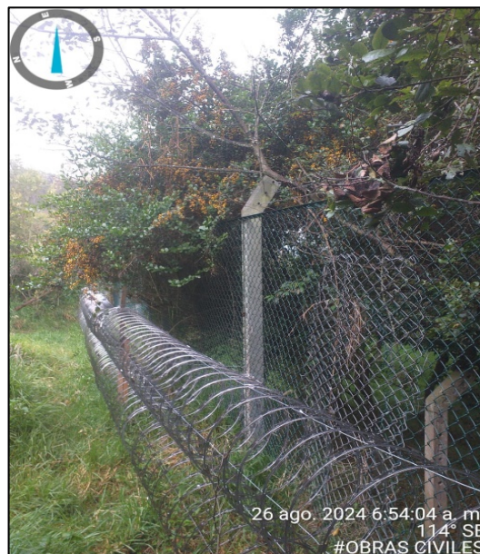
Fotografía 127. Instalación de concertina en cerramiento perimetral del tramo del dique VI
