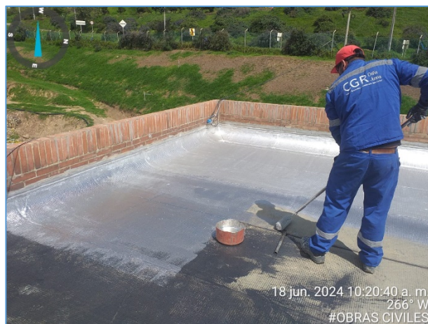
Fotografía 85. Mantenimiento general a contenedor ubicado en patio con trabajos de pintura interna y externa (izquierda) e impermeabilización de cubierta en el edificio principal de la PTL (derecha)
