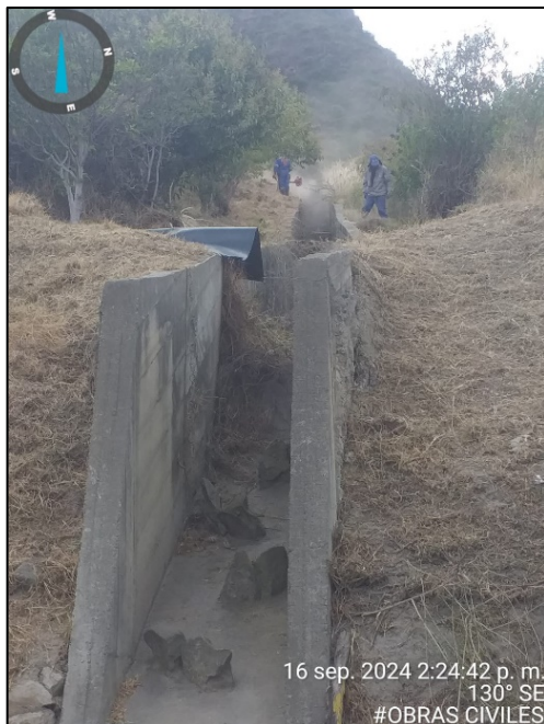
Fotografía 44. Mantenimiento y limpieza de canal de aguas lluvias en concreto ubicado en Zona IV (izquierda) y Recuperación de canal de aguas lluvias en el sector de Zona IV (derecha)
