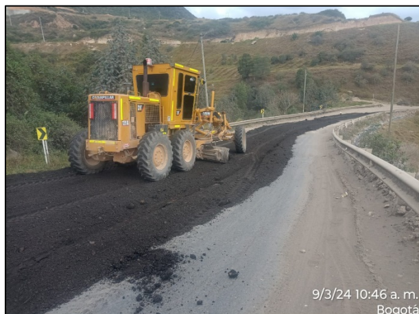
Fotografía 14. Instalación de material fresado para capa de rodadura por el sector de Zona IV – vía alterna.
