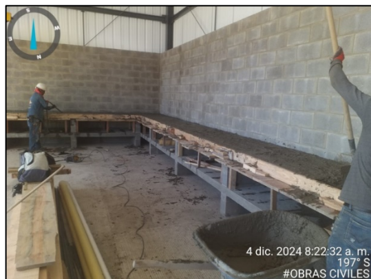
Fotografía 205. Construcción de mesones en concreto en el hangar de taller (izquierda) e instalación de cubierta perteneciente a la estructura del carcamo (derecha).
