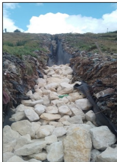
Fotografía 168. Adecuación de filtros de cierre - Zona de Optimización Fase I
