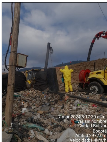
Fotografía 132. Mantenimiento y lavado de con equipo vector de succión - presión a tubería de extracción forzada perteneciente al Pozo 2
