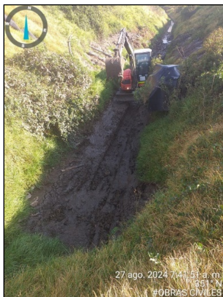
Fotografía 43. Recuperación de canal de aguas lluvias en el sector de Zona IV
