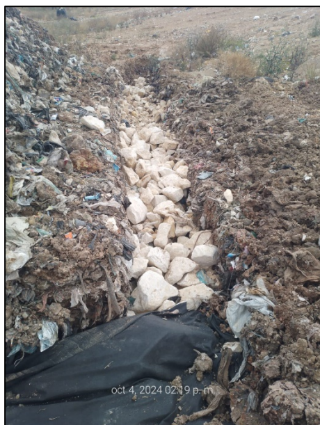
Fotografía 154. Atención brote de lixiviado ID 56 – Zona VII (izquierda) y Atención brote de lixiviado ID 54 – Pata de talud frente a CHP 310 (derecha)
