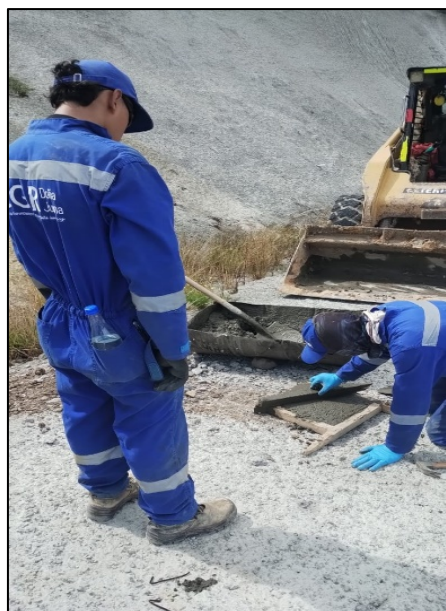
Fotografía 207. Instalación de mojones de topografía en talud poste "53"
