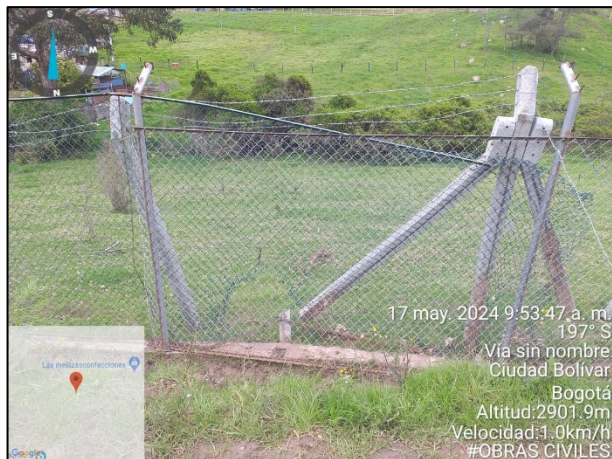
Fotografía 125. Instalación de postería en tubería galvanizada y malla eslabonada para reparación de tramos dañados del cerramiento perimetral.
