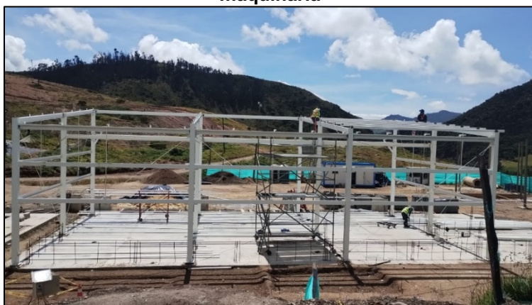
Fotografía 198. Armado de estructura metálica del hangar principal del nuevo taller de maquinaria
