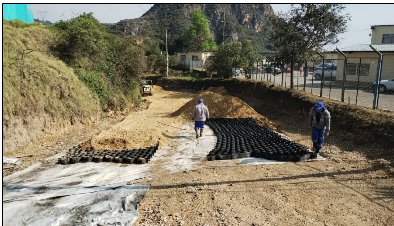
Fotografía 54. Instalación de geocelda en el K2+437 hasta el K2+460 en ambos costados.
