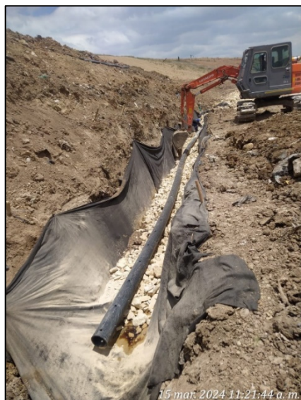
Fotografía 148. Equipamiento de filtro e instalación de tubería PEAD de 8" PN 12,5 - Biosolidos para corrección de brote de lixiviados
