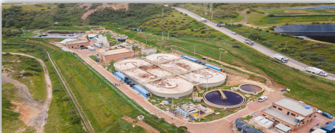
Fotografía 9. Panorámica se los SBRs
