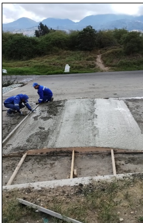
Fotografía 51. Construcción de reductores de velocidad en la báscula de salida
