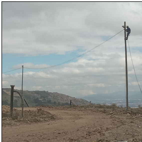
Fotografía 120. Traslado de redes eléctricas según avances de disgregación en frente de disposición
