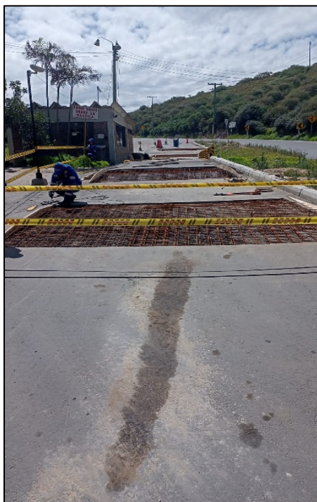
Fotografía 51. Construcción de reductores de velocidad en la báscula de salida
