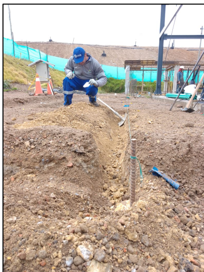
Fotografía 116. Excavación manual para instalación de tubería conduit – Nuevo taller de maquinaria (izquierda) y Traslado de redes eléctricas según avances de disgregación en frente de disposición (derecha)
