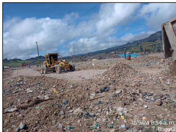
Fotografía 25. Refuerzo de capa de rodadura con aplicación de agregado reciclado en circuito de ingreso y salida del frente de descargue (izquierda) y Mantenimiento a capa de rodadura perteneciente a la vía alterna – Zona 4 aplicando material fresado de carpeta asfáltica (derecha).
