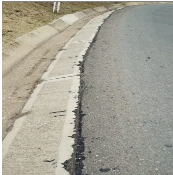
Fotografía 67. Sellado de juntas y fisuras en el tramo entre las abscisas K2+205 y K2+250 (Izquierda) y Construcción de cárcamo de aguas lluvias - bascula de emergencia (derecha)
