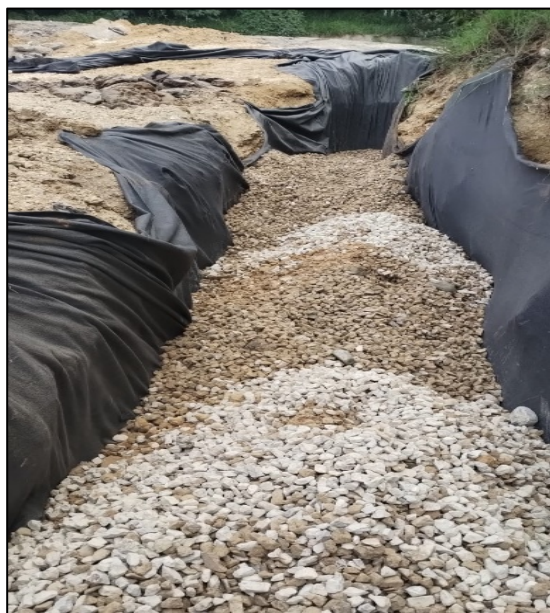
Fotografía 56. Construcción de subdrén entre las abscisas K2+240 y K2+270 - costado derecho
