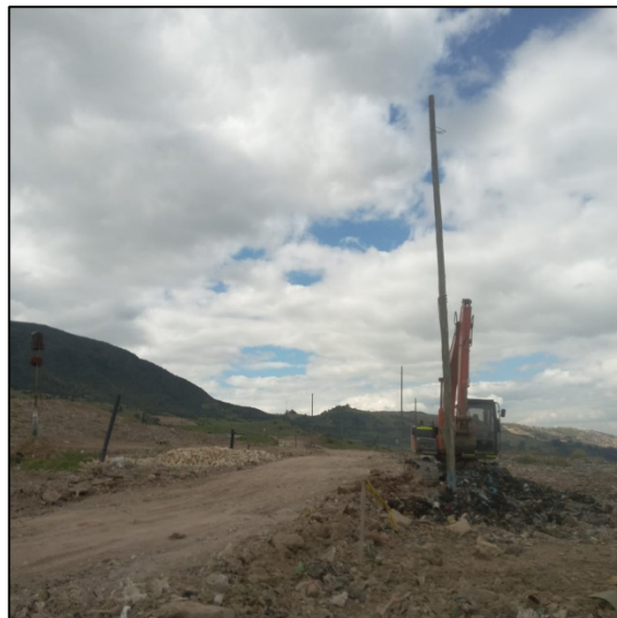
Fotografía 120. Traslado de redes eléctricas según avances de disgregación en frente de disposición
