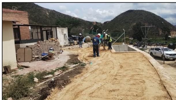
Fotografía 220. Llenos y compactación de material recebo para el confinamiento del muro de contención con la cimentación del edificio de la PTL
