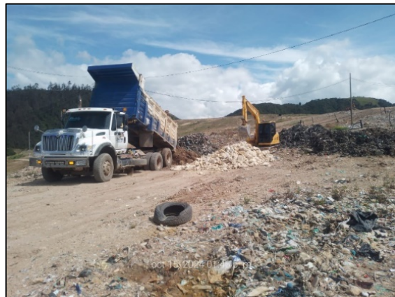
Fotografía 156. Corrección de Brote de lixiviado nuevo – CH245 (izquierda) y Corrección de Brote de lixiviado nuevo – Pozo 4 (derecha)
