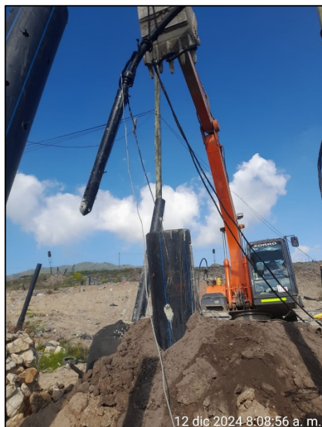
Fotografía 145. Limpieza y mantenimiento bomba de extracción forzada pozo 2 (izquierda) y limpieza de mangueras conductoras de lixiviado con vector (derecha)
