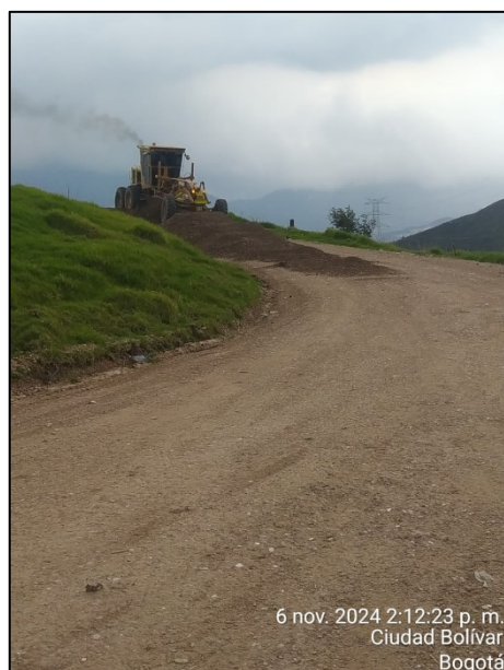
Fotografía 177. Instalación de material proveniente del proceso de RCD's y RPCC's como recebo en bermas de Biosólidos dentro del proceso de cierre definitivo
