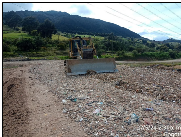
Fotografía 18. Construcción de nueva vía de acceso a plataforma de descargue terraza IV.
