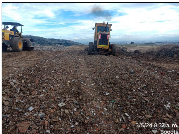
Fotografía 17. Refuerzo de capa de rodadura con material triturado reciclado en circuito de ingreso y salida del frente de descargue.
