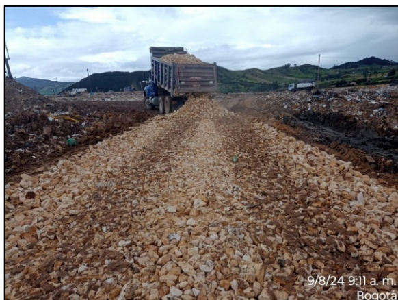
Fotografía 23. Mantenimiento y refuerzo de capa de rodadura con material triturado en piedra rajón de 4" a 6" en circuitos de disposición.
