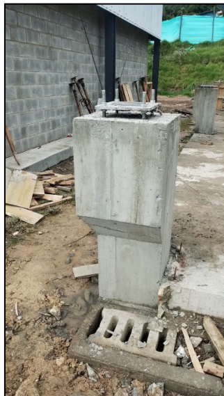
Fotografía 201. Construcción de ménsulas para soporte de estructura de acero – Cárcamo – Nuevo taller (izquierda) e instalación de pórtico en estructura metálica - Cárcamo Nuevo taller (derecha).
