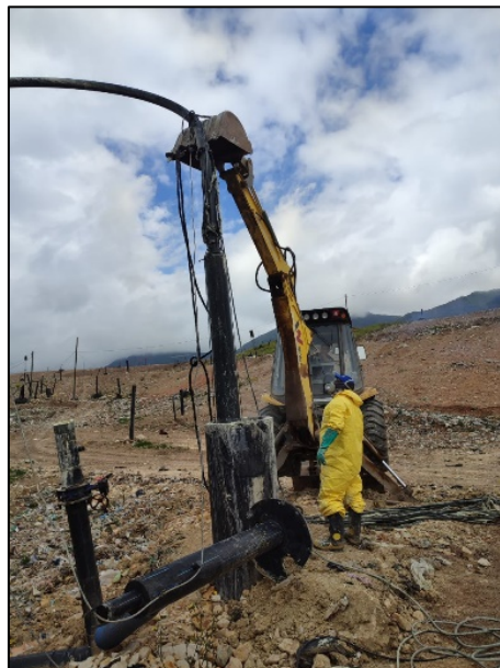
Fotografía 141. Mantenimiento y limpieza de bomba sumergible CHP 1035 (izquierda) y Pozo 1 (derecha)
