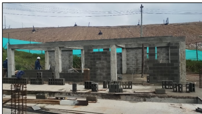
Fotografía 200. Construcción de mampostería y viga estructural perteneciente al cuarto de motores, bodega de repuestos y cuarto de aceites usados (izquierda) e Instalación de la perfilaría metálica para la cubierta – cuarto de aceites (derecha)
