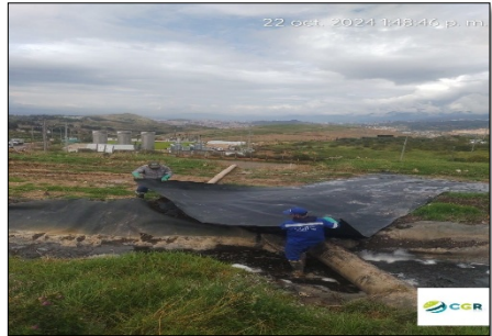
Cambio de geomembrana de los canales
