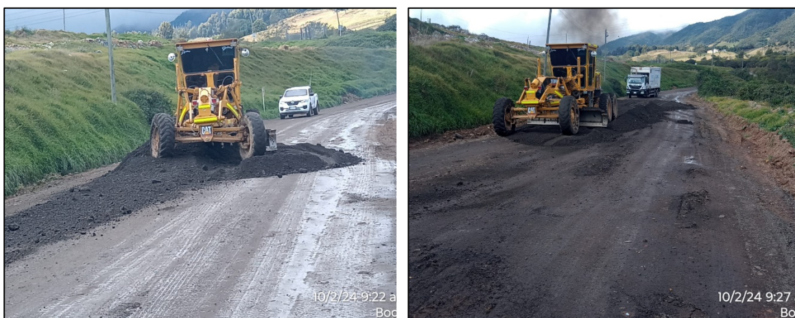
Fotografía 13. Instalación de material fresado de carpeta asfáltica por el sector de Zona VIII - vía de ingreso y salida del frente de descarga.
