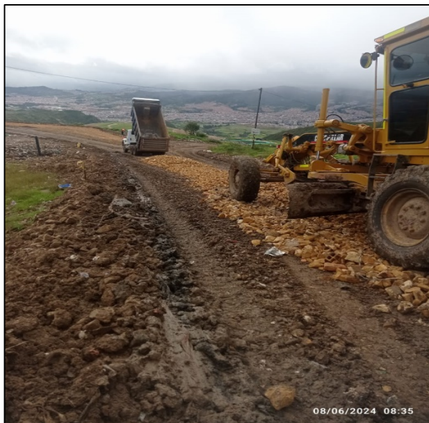
Fotografía 20. Refuerzo de capa de rodadura con material triturado en piedra rajón de 4" a 6" en circuito de ingreso y salida del frente de descargue.
