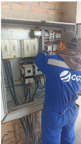
Fotografía 114. Mantenimiento a circuitos de energía correspondientes a la planta del SBR (izquierda) e instalación de reflectores adicionales a la red de iluminación de la planta de RCD's (derecha)
