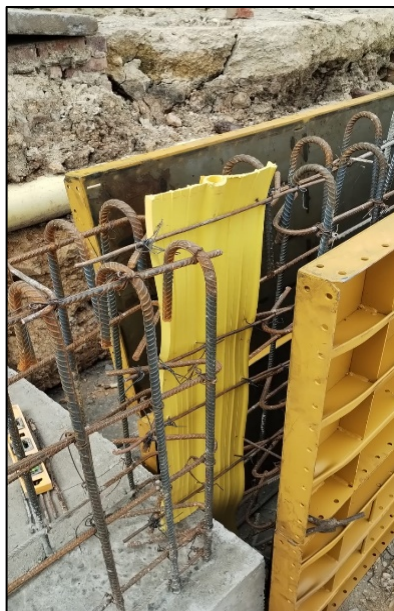
Fotografía 215. Armado de formaleta metálica para construcción de muro de construcción PTL
