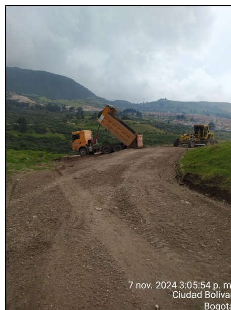
Fotografía 177. Instalación de material proveniente del proceso de RCD's y RPCC's como recebo en bermas de Biosólidos dentro del proceso de cierre definitivo
