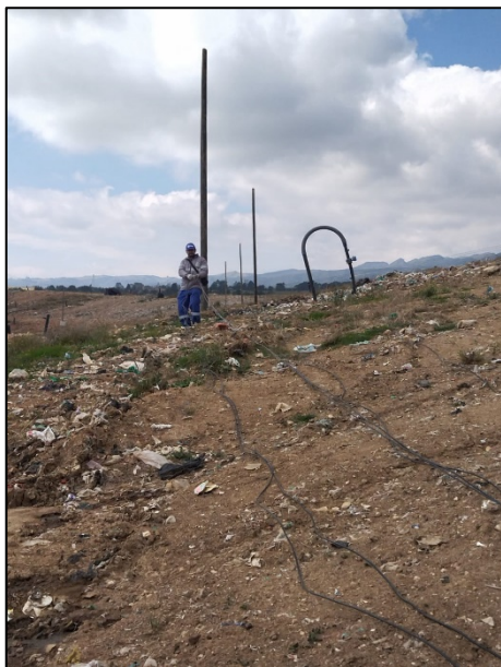
Fotografía 101. Instalación de postes de madera inmunizados y accesorios para nueva red eléctrica de alumbrado en fase 2
