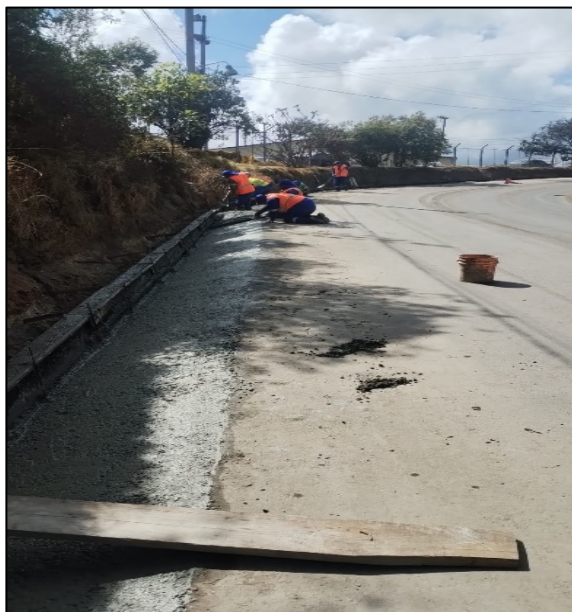
Fotografía 66. Construcción de cunetas perimetrales en concreto reforzado entre el K2+370 y K2+445 – costado izquierdo (izquierda) e Instalación de mezcla asfáltica frente al campamento principal entre el K2+455 al K2+480 (derecha)
