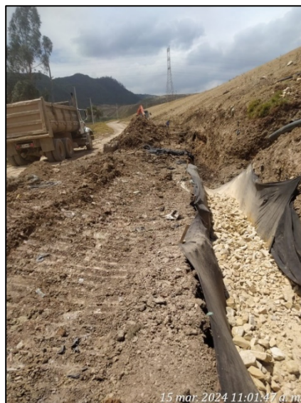
Fotografía 148. Equipamiento de filtro e instalación de tubería PEAD de 8" PN 12,5 - Biosolidos para corrección de brote de lixiviados
