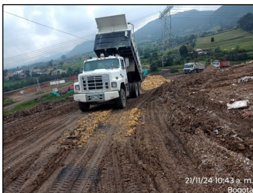
Fotografía 29. Refuerzo de capa de rodadura con material triturado en piedra rajón de 4" a 6" (izquierda) y agregado seleccionado (derecha) en circuito de ingreso y salida del frente de descargue.
