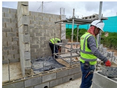
Fotografía 196. Levantes en mampostería para la construcción del cuarto de aceites, cuarto de motores y de repuestos del nuevo taller de maquinaria
