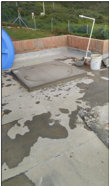
Fotografía 80. Construcción de placa para tanque elevado en cubierta superior del edificio de la PTL (izquierda) y subestación eléctrica de la planta del SBR (derecha)
