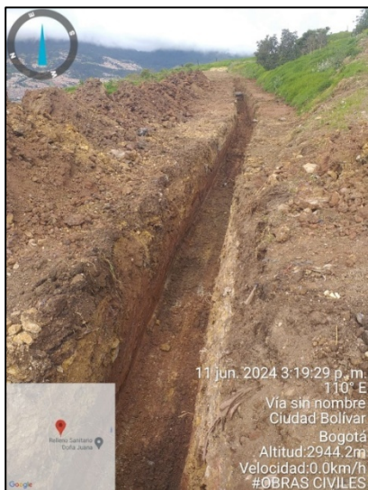
Fotografía 166. Adecuación de filtros geotextil de 119 gr/m2 y piedra rajón del 10" - filtros de cierre Zona de Optimización Fase I
