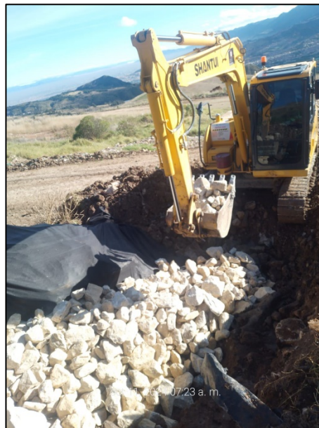
Fotografía 155. Inicio de excavación para atención de brote nuevo – Terraza III. (izquierda) y atención brote de lixiviado ID 63 – Zona VII, caseta 1 (derecha)
