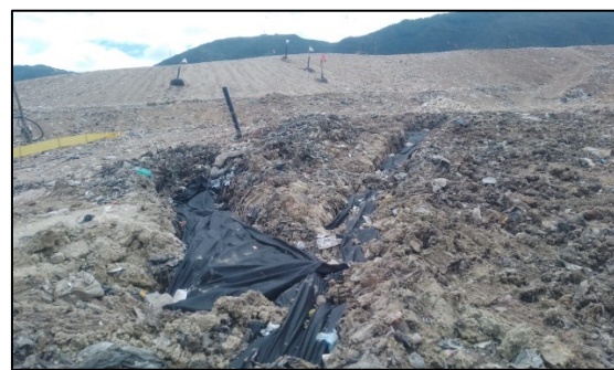
Fotografía 152. Corrección de brote lixiviado 48. – Frente a zona de corte y pegue de tubería (izquierda) y Corrección de brote lixiviado 62 – Ferrari (derecha)
