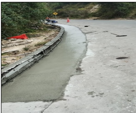
Fotografía 63. Construcción de cunetas desde el K2+230 hasta el K2+370 – costado izquierdo (izquierda) Conformación de terreno e instalación de acero de refuerzo para construcción de cuneta perimetrales en el tramo entre las abscisas K2+210 al K2+400 - costado izquierdo (derecha)
