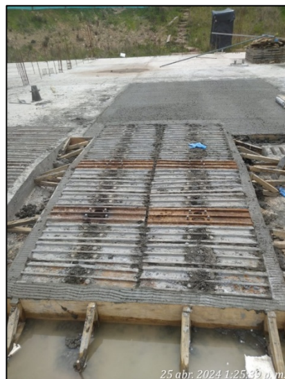
Fotografía 193. Fundida en concreto reforzado de placa de cimentación y rampas de acceso
