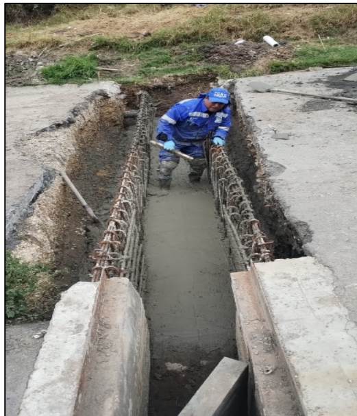
Fotografía 67. Sellado de juntas y fisuras en el tramo entre las abscisas K2+205 y K2+250 (Izquierda) y Construcción de cárcamo de aguas lluvias - bascula de emergencia (derecha)
