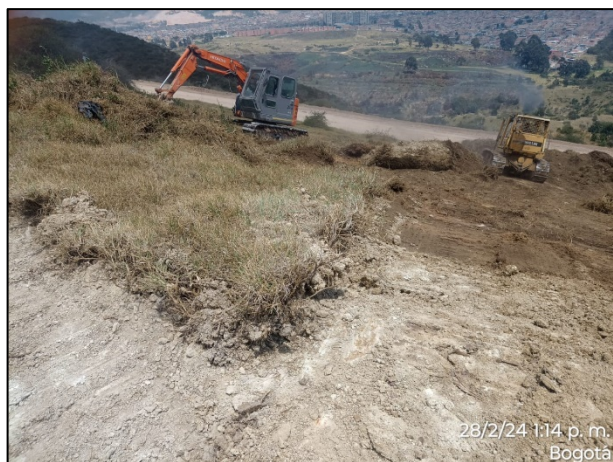
Fotografía 182. Descapote en el proceso del cierre definitivo de Zona II - Área 3
