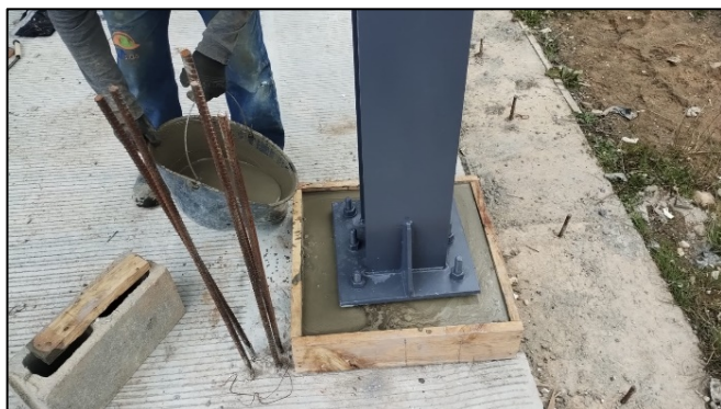
Fotografía 199. Instalación de groutin de nivelación en las bases de las columnas metálicas. (Izquierda) e Instalación de la mampostería perimetral del hangar. (derecha)
