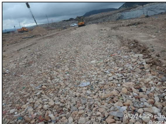
Fotografía 32. Mantenimiento a capa de rodadura en vías operativas con triturado de 4” a 6” y RPCC – Frente de disposición.
