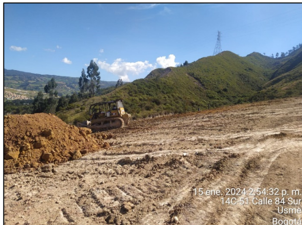
Fotografía 181. Instalación de arcilla en cierre de Zona II - Área 3
