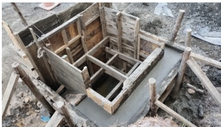
Fotografía 62. Fundida en concreto para construcción de cunetas perimetrales en el tramo entre las abscisas K2+200 y K2+480- costado derecho (izquierda) y construcción de poceta en concreto reforzado para recolección de aguas lluvias de las cunetas y entrega a la red en tubería corrugada de 15" de diámetro que entrega su caudal a los descoles de la vía principal en el sector de la portería principal – K0+110 costado derecho (Derecha)
