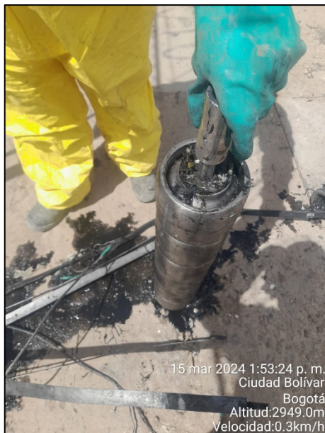
Fotografía 133. Mantenimiento y limpieza de bomba sumergible marca Franklin Electric de 20 hp – CHP 1075
