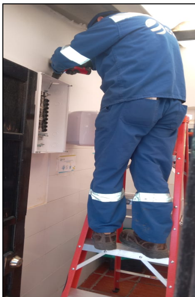
Fotografía 103. Cambio de acometida del circuito eléctrico de monofásico a trifásico – campamento cancha
