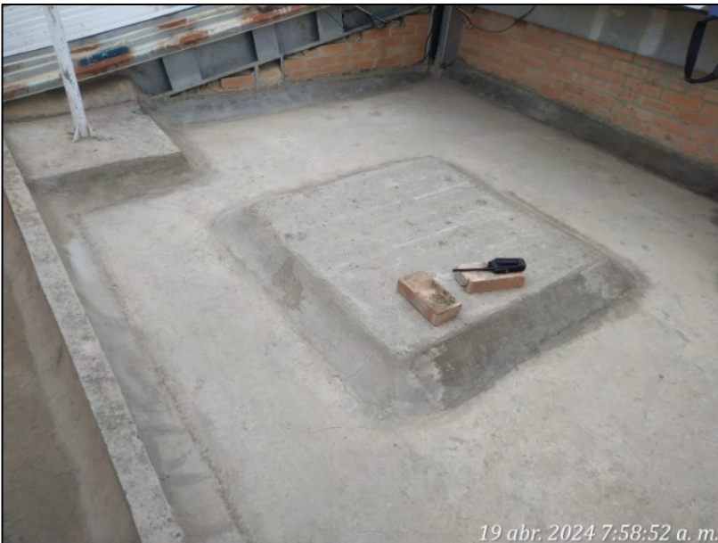
Fotografía 80. Construcción de placa para tanque elevado en cubierta superior del edificio de la PTL (izquierda) y subestación eléctrica de la planta del SBR (derecha)
