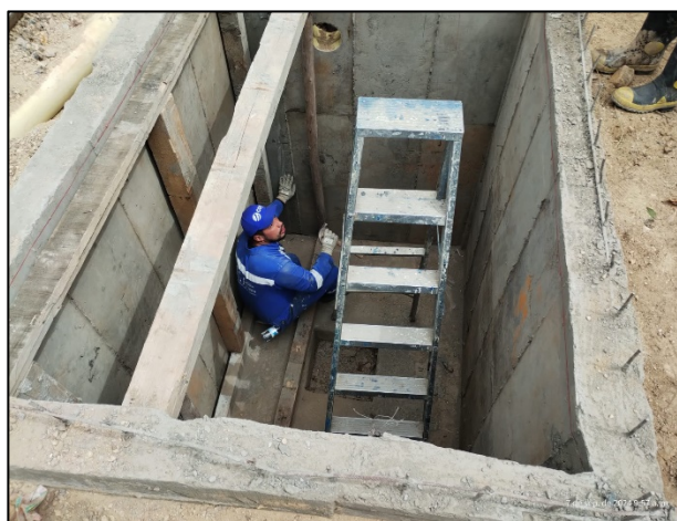
Fotografía 91. Impermeabilización con manto asfáltico en terraza del segundo nivel – Oficina principal PTL (izquierda) y Terminación de construcción de tanque de almacenamiento en concreto reforzado para aguas de escorrentías – Zona de reservorio (derecha)
