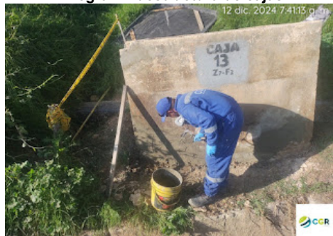
Arreglo infraestructura de cajas
