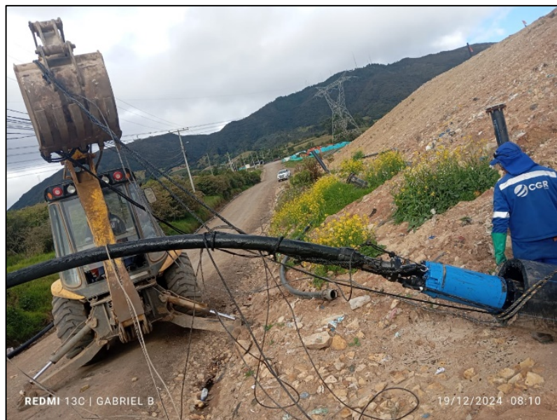
Fotografía 146. Mantenimiento bomba de extracción forzada lateral 3B (Izquierda) y Foso cementerio (Derecha)
