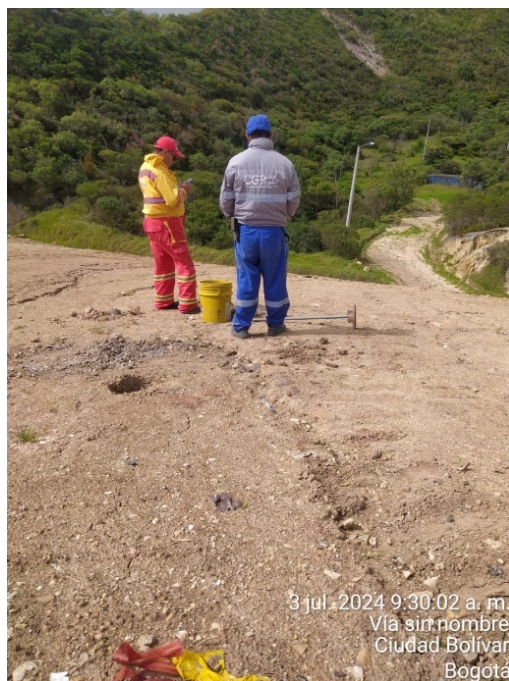
Fotografía 186. Ensayos de permeabilidad in situ en Zona II - Área 3
