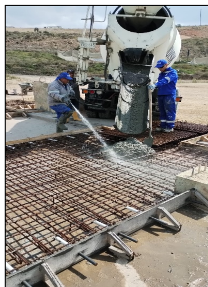
Fotografía 192. Fundida en concreto reforzado de placa de cimentación y rampas de acceso
