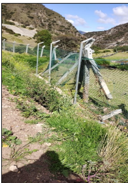
Fotografía 124. Instalación de postería en tubería galvanizada para reparación de tramos dañados del cerramiento perimetral
