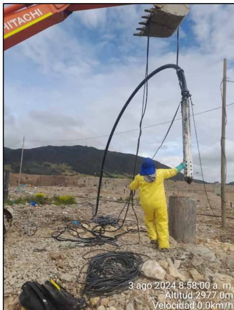
Fotografía 140. Limpieza de pozo CH 1070 e instalación de bomba sumergible tipo (izquierda) y Mantenimiento y limpieza de bomba sumergible – terraza 3ª (derecha) y Pozo 5 (derecha)
