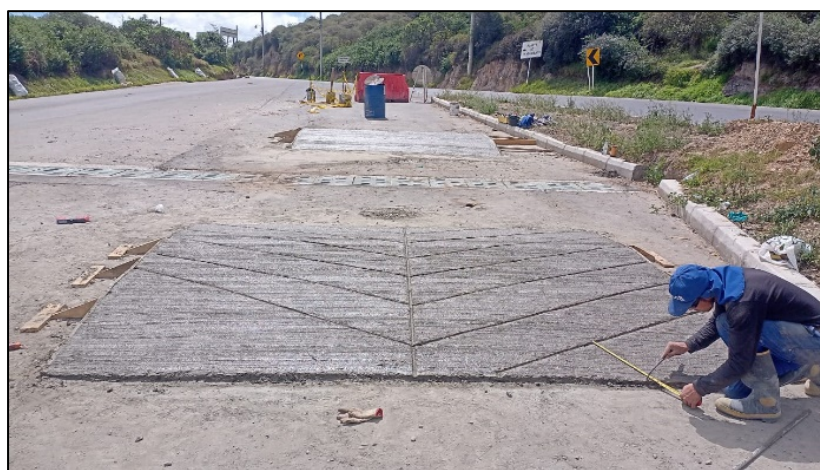
Fotografía 52. Construcción de reductores de velocidad en la báscula de salida (izquierda) y sellado de juntas de dilatación, fisuras y grietas sobre la rasante de la vía principal (derecha)
