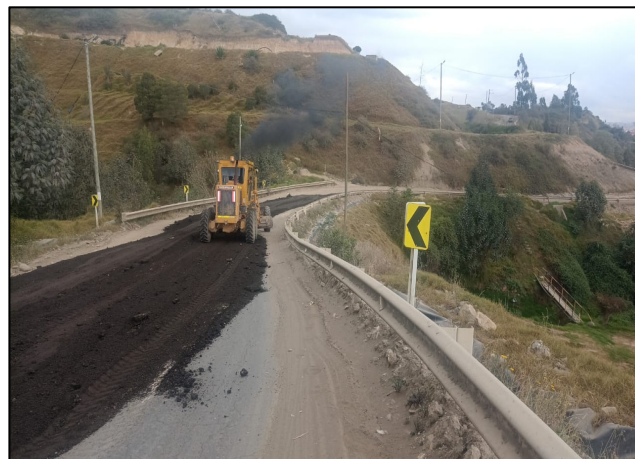
Fotografía 14. Instalación de material fresado para capa de rodadura por el sector de Zona IV – vía alterna.
