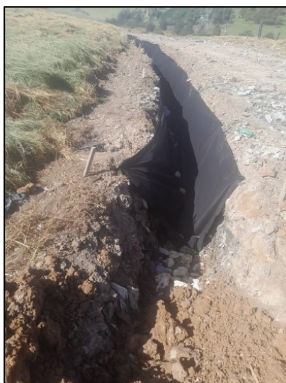
Fotografía 169. Adecuación de filtros de cierre - Zona de Optimización Fase I.
