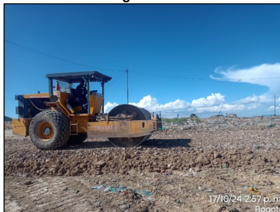
Fotografía 28. Refuerzo de capa de rodadura con aplicación de agregado reciclado en circuito de ingreso y salida del frente de descargue.
