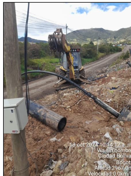
Fotografía 142. Mantenimiento y limpieza a bomba de extracción forzada de lixiviado – terraza 4 (izquierda) y realce de tubería de encamisado del pozo lateral 3B (derecha)
