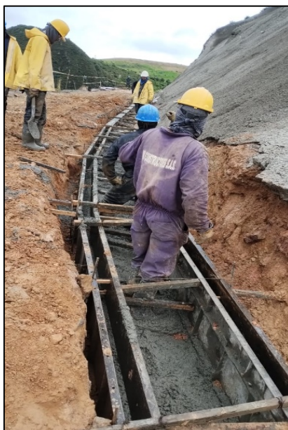
Fotografía 209. Construcción de cunetas en concreto reforzado con fibras de polipropileno. – berma 1 - talud “Poste 53”
