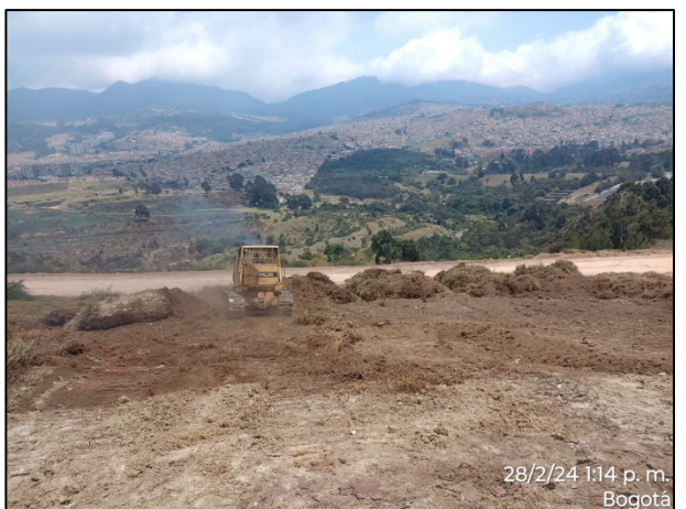
Fotografía 182. Descapote en el proceso del cierre definitivo de Zona II - Área 3
