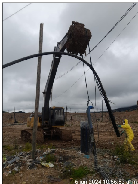
Fotografía 137. Mantenimiento y limpieza de bomba sumergible – Pozo 5
