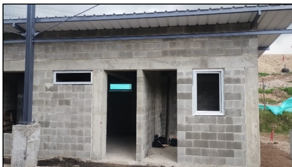
Fotografía 225. Instalacion de ventanas en pvc (izquierda) y terminación de cuchillas en mampostería en oficinas nuevo campamento (derecha)
