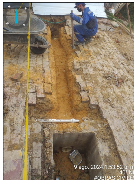
Fotografía 89. Instalación de puerta metálica para acceso a cuarto de almacenamiento - oficina taller temporal (izquierda) y Modificación de descole de drenaje de aguas lluvias en edificio – PTL. (derecha)
