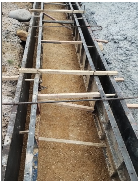
Fotografía 208. Armado de formaleta metálica para construcción de cuneta perimetral – berma 1 / Poste 53
