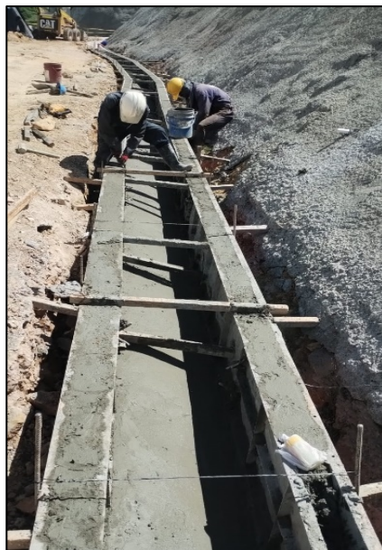
Fotografía 210. Fundida en concreto reforzado para construcción de cuneta – berma 1 – talud “Poste 53”
