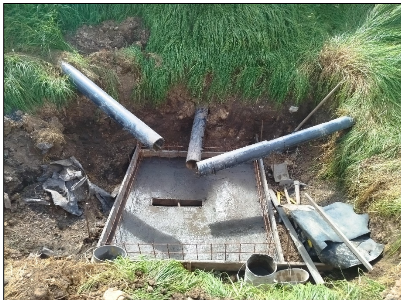
Fotografía 98. Construcción de caja 11 en concreto reforzado – línea de conducción de lixiviado – biogás. (izquierda) e Instalación de piso vinilo SPC tráfico pesado perteneciente al contenedor de topografía – Nuevo campamento(derecha)
