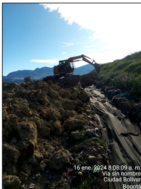
Fotografía 163. Adecuación de filtros geotextil de 119 gr/m2 y piedra rajón del 10" - filtros del cierre de Optimización Fase I
