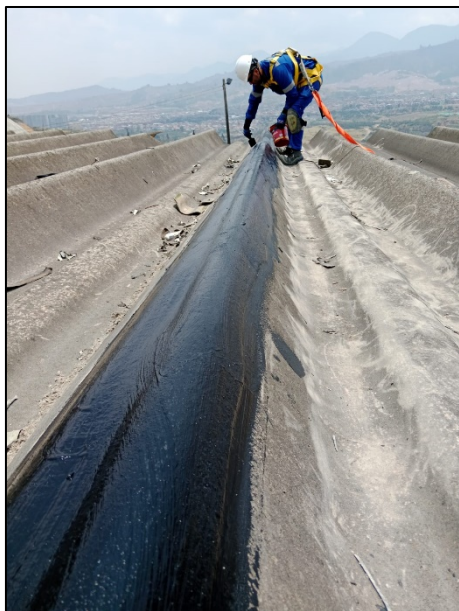
Fotografía 78. Reparación de fisura en cubierta sobre oficina de talento humano – campamento principal (izquierda) y Poda perimetral al cerramiento en Dique IV (derecha)
