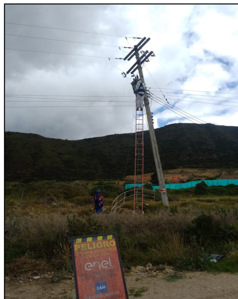
Fotografía 107. Acompañamiento a cuadrilla técnicos de ENEL/CODENSA en zona taller, revisión de transformador 30 kva para marcación y toma de muestras al aceite refrigerante
