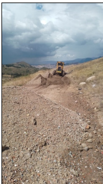
Fotografía 175. Culminación prueba de instalación de material proveniente del proceso de RCD's y RPCC's como recebo en bermas de Biosólidos dentro del proceso de cierre definitivo
