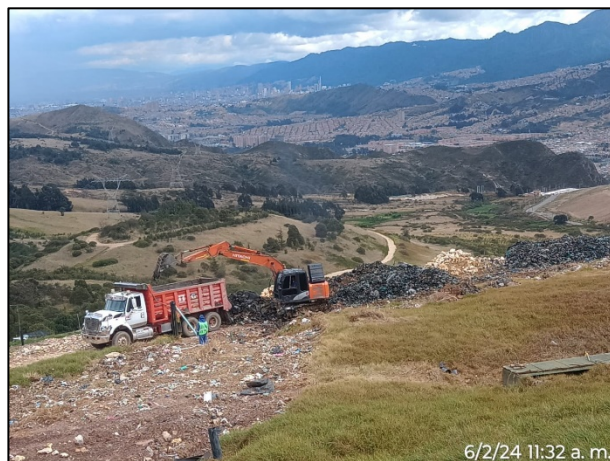
Fotografía 164. Adecuación de filtros con geotextil de 119 gr/m2 y piedra rajón del 10" - filtros del cierre de Optimización Fase I
