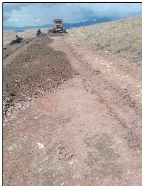
Fotografía 176. Instalación de material proveniente del proceso de RCD's y RPCC's como recebo en bermas de Biosólidos dentro del proceso de cierre definitivo
