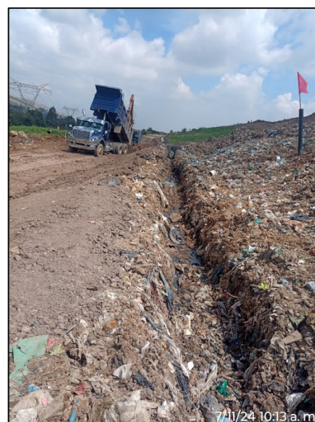
Fotografía 171. Adecuación de filtros de cierre - Zona de Optimización Fase I.
