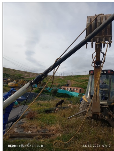
Fotografía 146. Mantenimiento bomba de extracción forzada lateral 3B (Izquierda) y Foso cementerio (Derecha)
