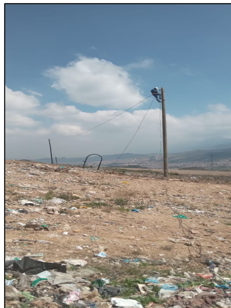
Fotografía 101. Instalación de postes de madera inmunizados y accesorios para nueva red eléctrica de alumbrado en fase 2
