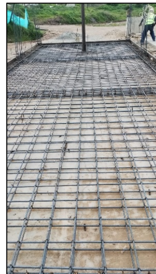
Fotografía 195. Amarre de acero para la construcción de placa de cimentación perteneciente al cuarto de aceites de nuevo taller
