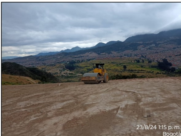
Fotografía 187. Compactación de complemento de capa de arcilla en Zona II - Área 3.
