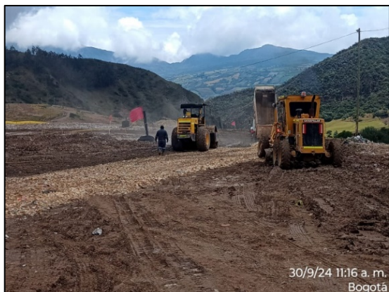
Fotografía 26. Refuerzo de capa de rodadura con material triturado en piedra rajón de 4” a 6” en circuito de ingreso y salida del frente de descargue (izquierda) y Mantenimiento a capa de rodadura perteneciente a la vía alterna – Zona 4 aplicando material fresado de carpeta asfáltica (derecha).
