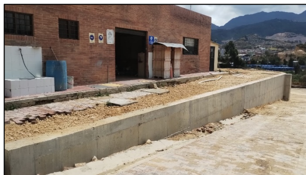
Fotografía 220. Llenos y compactación de material recebo para el confinamiento del muro de contención con la cimentación del edificio de la PTL
