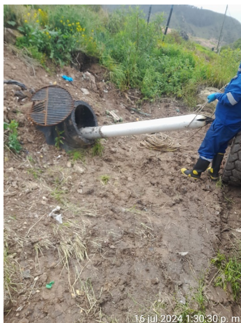
Fotografía 138. Reinstalación de bomba sumergible – Pozo de terraza 3B (Izquierda) y Limpieza de pozo CH 1070 como preparación para instalación de bomba sumergible (Derecha)
