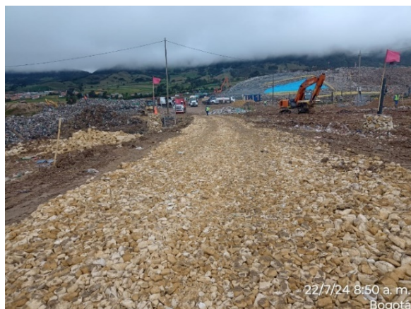
Fotografía 21. Mantenimiento y refuerzo de capa de rodadura con triturado en piedra rajón de 4" a 6" y agregado seleccionado en vía de ingreso al frente de disposición.
