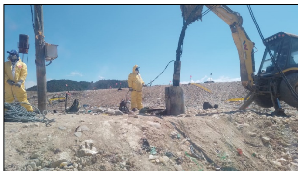
Fotografía 134. Mantenimiento y limpieza de bomba sumergible marca Franklin Electric de 20 hp – Pozo 1
