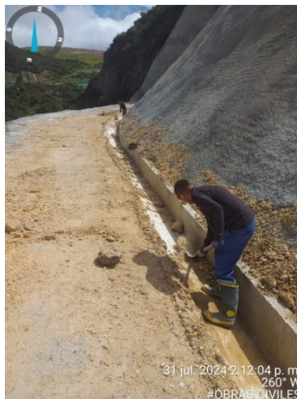
Fotografía 212. Fundida de disipadores de energía – berma 3 de talud “Poste 53” (izquierda) y limpieza de cunetas recientemente construidas y relleno de espacios entre zanja de excavación y cuneta construida – berma 2 talud “Poste 53” (derecha)
