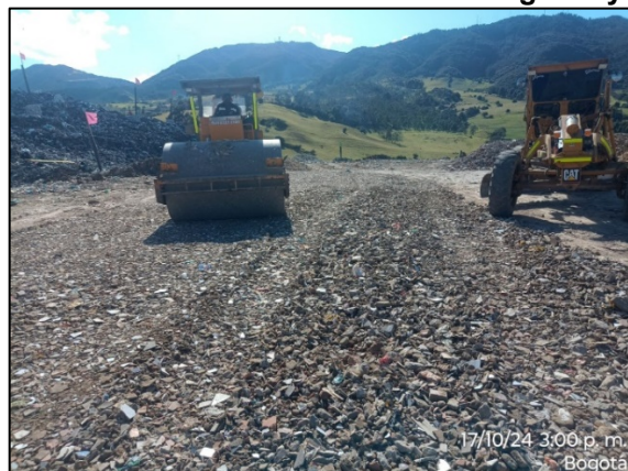
Fotografía 28. Refuerzo de capa de rodadura con aplicación de agregado reciclado en circuito de ingreso y salida del frente de descargue.
