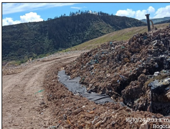
Fotografía 156. Corrección de Brote de lixiviado nuevo – CH245 (izquierda) y Corrección de Brote de lixiviado nuevo – Pozo 4 (derecha)
