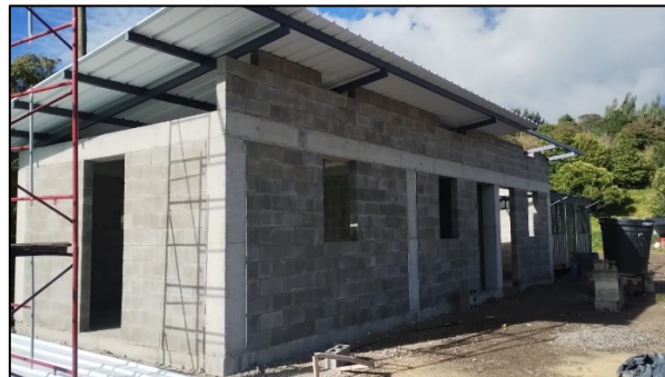
Fotografía 225. Instalacion de ventanas en pvc (izquierda) y terminación de cuchillas en mampostería en oficinas nuevo campamento (derecha)
