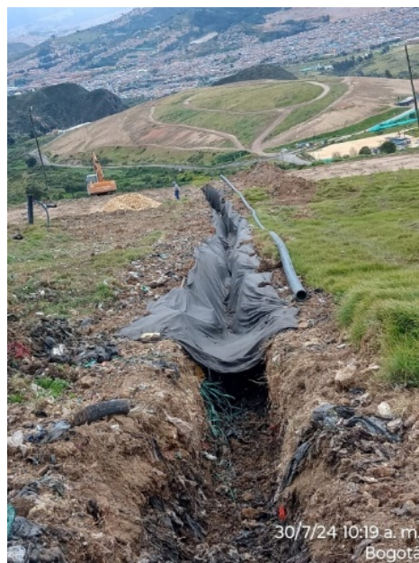
Fotografía 167. Adecuación de filtros de cierre - Zona de Optimización Fase I
