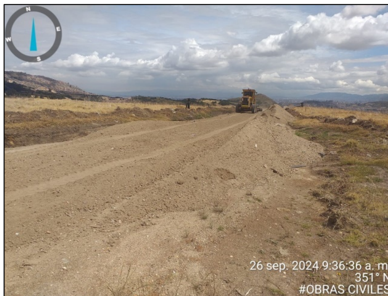
Fotografía 175. Culminación prueba de instalación de material proveniente del proceso de RCD's y RPCC's como recebo en bermas de Biosólidos dentro del proceso de cierre definitivo
