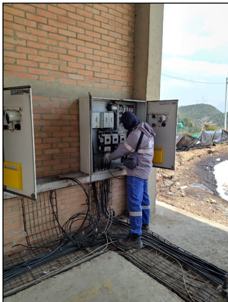
Fotografía 100. Revisión y mantenimiento de circuitos en tableros principales perteneciente a SBR
