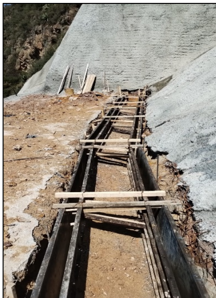
Fotografía 208. Armado de formaleta metálica para construcción de cuneta perimetral – berma 1 / Poste 53
