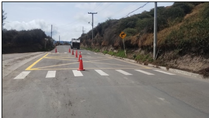
Fotografía 65. Construcción de rampa de acceso en concreto reforzado para ingresar al acopio de tubería en la abscisa K2+480 (izquierda) y Demarcación y pintura de señalización horizontal para paso peatonal en desvío hacia la PTL (derecha).
