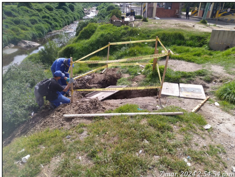
Fotografía 76. Arreglo de fuga en acometida principal del acueducto – Avenida Boyacá
