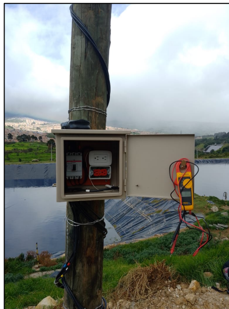
Fotografía 111. Pruebas de funcionamiento y medición de carga a los circuitos de iluminación del relleno sanitario
