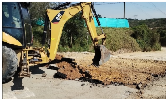
Fotografía 55. Demolición y retiro de la carpeta asfáltica existente entre las abscisas K2+440 y K2+460
