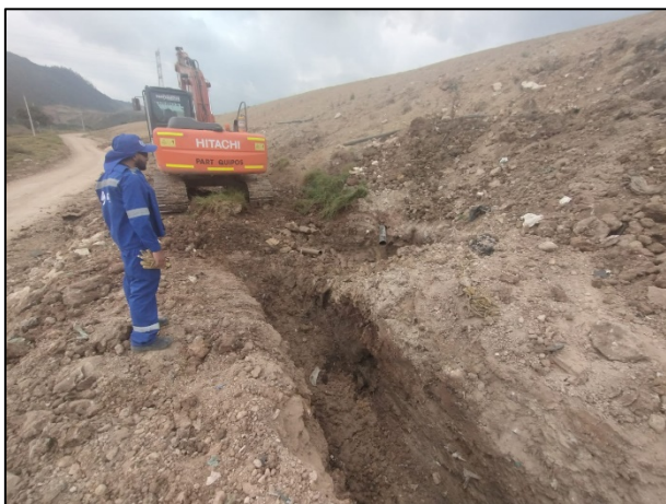
Fotografía 147. Excavación para instalación de tuberías en el sector de Mansión - Biosolidos para corrección de brote de lixiviados
