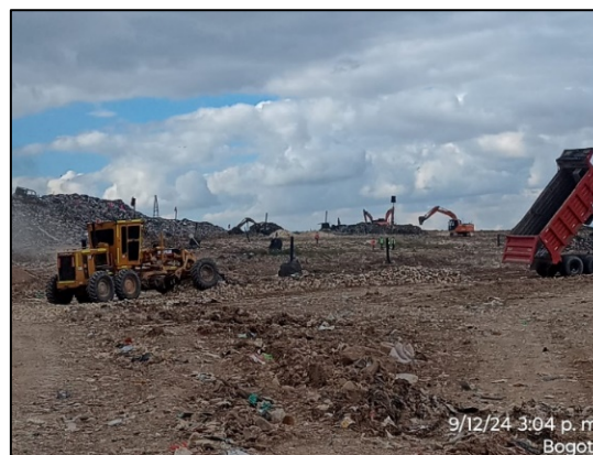
Fotografía 31. Adecuacion de via para accezo a zona 8 – Frente de disposición (izquierda) y mantenimiento a capa de rodadura en vías operativas con triturado de 4" a 6" – Frente de disposicion (derecha)
