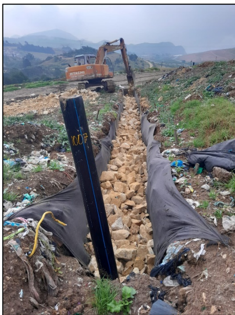
Fotografía 165. Adecuación de filtros geotextil de 119 gr/m2 y piedra rajón del 10" - filtros de cierre Zona de Optimización Fase I
