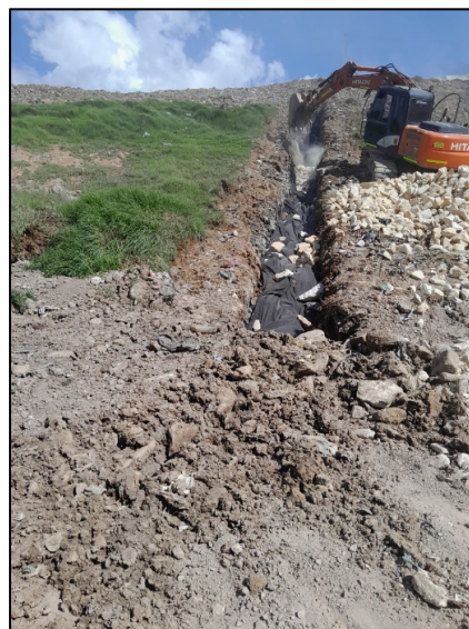
Fotografía 172. Adecuación de filtros de cierre - Zona de Optimización Fase I.
