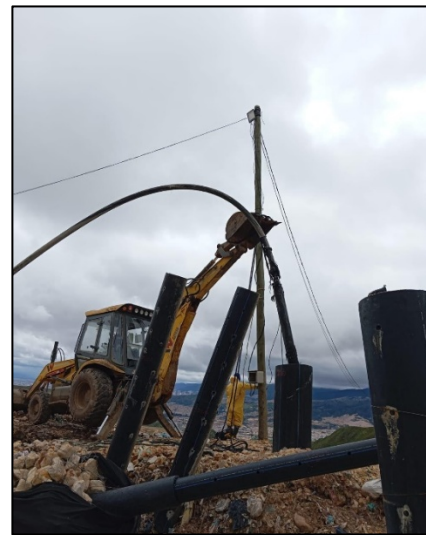
Fotografía 136. Mantenimiento y limpieza de bomba sumergible marca Franklin - Pozo 1 (izquierda) y Mantenimiento y limpieza de bomba sumergible marca Franklin – Pozo 4 (derecha)
