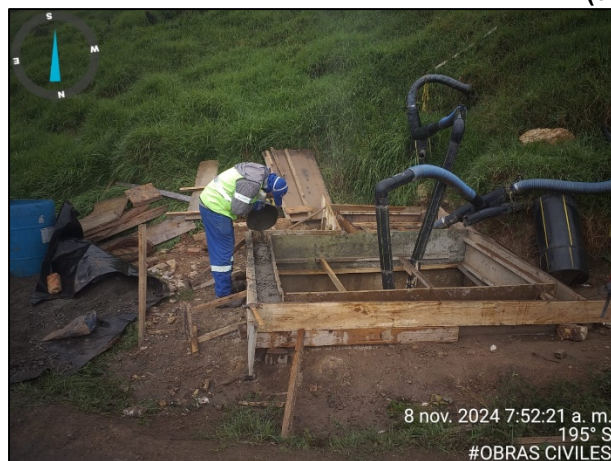
Fotografía 95. Realce a cajas de inspección del sistema de conducción de lixiviados frente a Pondaje VII (izquierda) y limpieza y retiro de lodos en oficina del área social – Mochuelo Alto (derecha)
