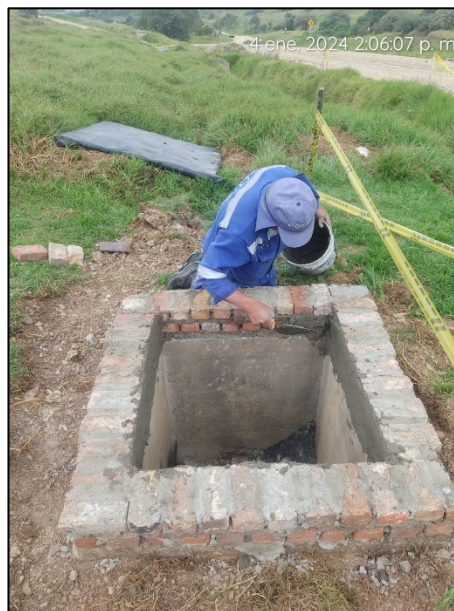
Fotografía 72. Mantenimiento a cajas de lixiviados ubicadas en Zona I Área 2.
