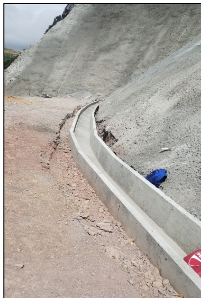
Fotografía 210. Fundida en concreto reforzado para construcción de cuneta – berma 1 – talud “Poste 53”
