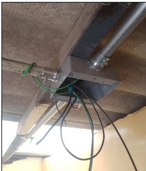
Fotografía 105. Cambio de acometida del circuito eléctrico de monofásico a trifásico – campamento Zona VIII
