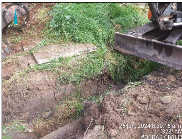
Fotografía 40. Limpieza de cuneta de agua lluvia con miniexcavadora – Zona IV
