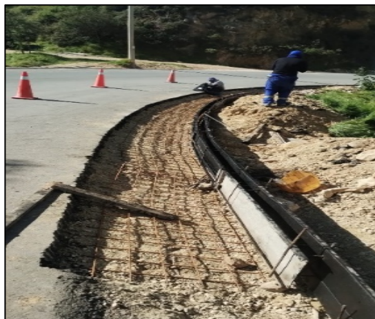
Fotografía 63. Construcción de cunetas desde el K2+230 hasta el K2+370 – costado izquierdo (izquierda) Conformación de terreno e instalación de acero de refuerzo para construcción de cuneta perimetrales en el tramo entre las abscisas K2+210 al K2+400 - costado izquierdo (derecha)
