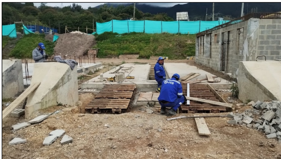
Fotografía 197. Construcción de rampa de acceso al cárcamo de lavado del nuevo taller de maquinaria.
