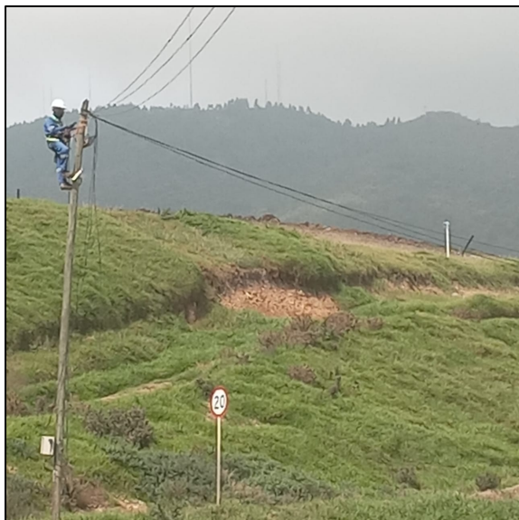
Fotografía 118. Reparación de red de iluminación por sobre voltaje desde la yee de biogás hasta vía Puente Tierra (izquierda) y cambio del cableado de control y conexión al tablero de la transferencia automática planta generadora de energía – Campamento Principal (derecha)
