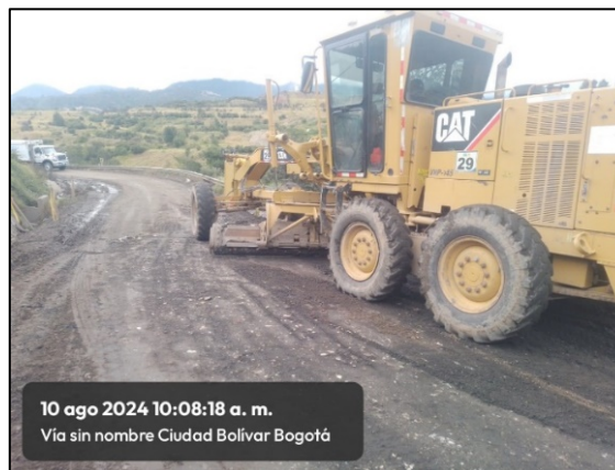
Fotografía 24. Mantenimiento a capa de rodadura perteneciente a la vía alterna – zona 4.
