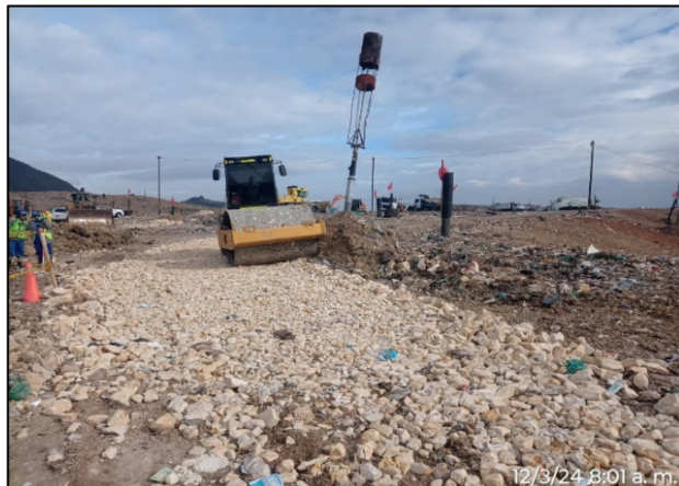
Fotografía 15. Refuerzo de capa de rodadura con material triturado en piedra rajón de 4" a 6" en circuito de ingreso y salida del frente de descargue.
