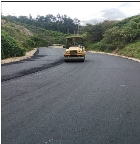
Fotografía 59. Compactación de capa de rodadura entre las abscisas K2+315 y K2+460 en ambos carriles y desde el K2+460 al K2+480 en el costado derecho
