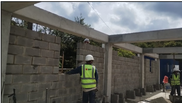
Fotografía 224. Construcción de mampostería en oficinas (izquierda) e instalación de perfilera metálica (derecha) para cubierta de taller, vestieres del área ambiental, taller, y cuarto de insumos químicos
