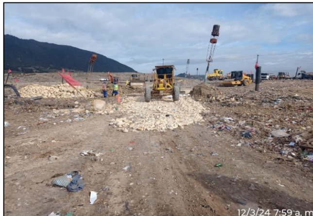
Fotografía 15. Refuerzo de capa de rodadura con material triturado en piedra rajón de 4" a 6" en circuito de ingreso y salida del frente de descargue.
