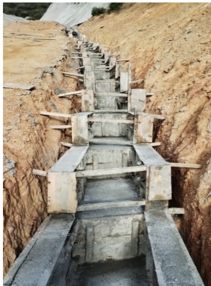
Fotografía 212. Fundida de disipadores de energía – berma 3 de talud “Poste 53” (izquierda) y limpieza de cunetas recientemente construidas y relleno de espacios entre zanja de excavación y cuneta construida – berma 2 talud “Poste 53” (derecha)
