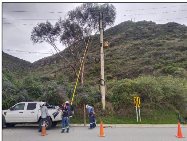
Fotografía 109. Cambio de corta circuitos completos (incluyendo cañuelas) y cables secundarios perteneciente a red de media tensión en transformador bifásico ubicado en el poste 33 – vía principal
