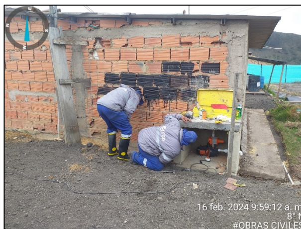
Fotografía 73. Instalación de sistema de presurización de suministro de agua la red hidráulica de la batería de baños y la cocineta ubicados en el campamento de Zona VIII.
