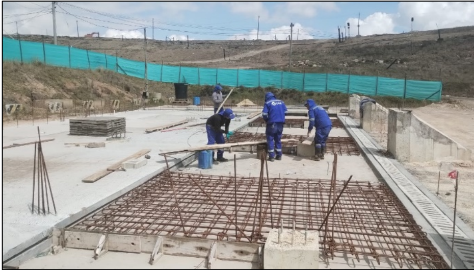
Fotografía 191. Figurado y armado de acero para rampas de acceso.
