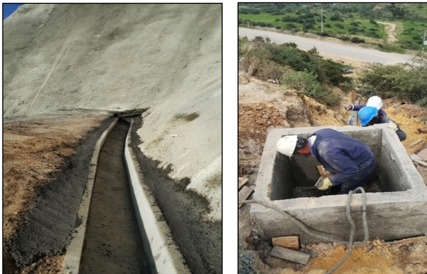
Fotografía 214. Lleno y sellado en concreto en los espacios que quedan entre las zanjas de la excavación y las estructuras de drenaje construidas (izquierda) y construcción de caja de inspección de la red de drenaje de aguas lluvias – Talud Poste 53 (derecha)
