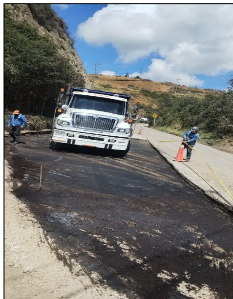
Fotografía 66. Construcción de cunetas perimetrales en concreto reforzado entre el K2+370 y K2+445 – costado izquierdo (izquierda) e Instalación de mezcla asfáltica frente al campamento principal entre el K2+455 al K2+480 (derecha)
