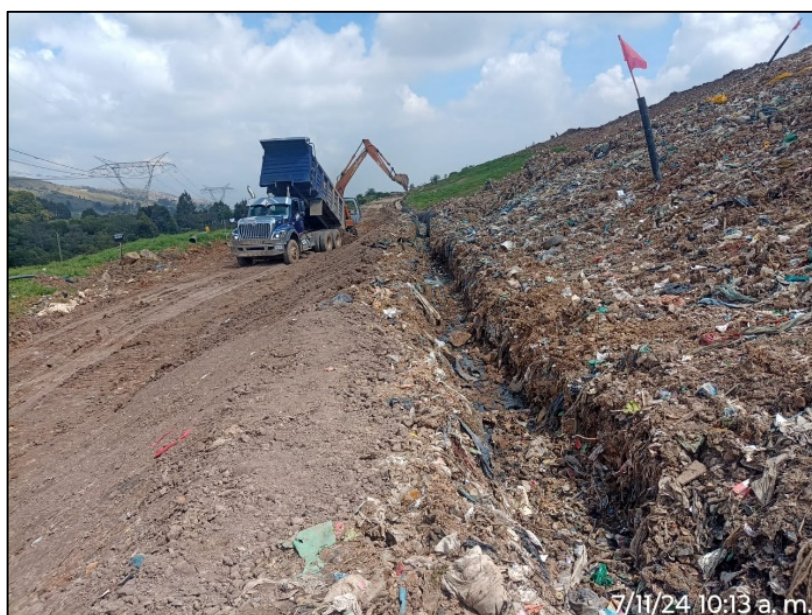
Fotografía 171. Adecuación de filtros de cierre - Zona de Optimización Fase I.
