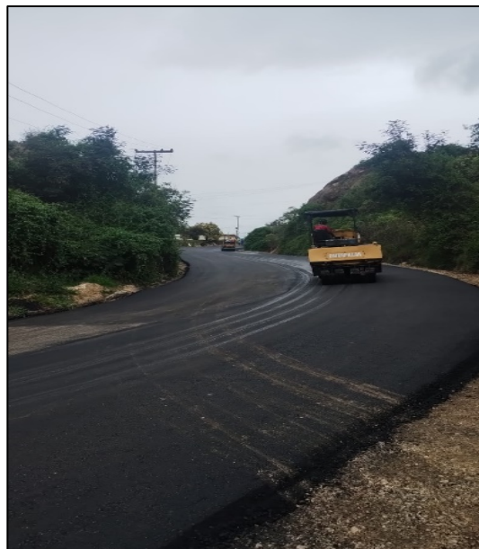
Fotografía 59. Compactación de capa de rodadura entre las abscisas K2+315 y K2+460 en ambos carriles y desde el K2+460 al K2+480 en el costado derecho
