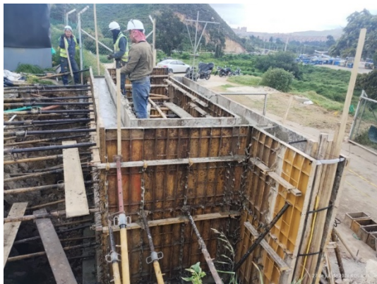
Fotografía 217. Vaciado de concreto, retiro de formaleta e instalación de geodrén para construcción de muro de contención – Sección No. 6 - PTL.
