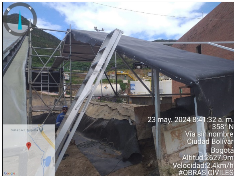
Fotografía 82. Aplicación de anticorrosivo a estructura metálica de cubierta del deshidratador de lodos (izquierda) y construcción de anclaje y mantenimiento a membrana lisa perteneciente al deshidratador de lodos – PTL (derecha)
