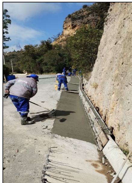
Fotografía 53. Construcción de cunetas perimetrales en concreto reforzado en el tramo entre las abscisas K2+150 y K2+205 costado derecho
