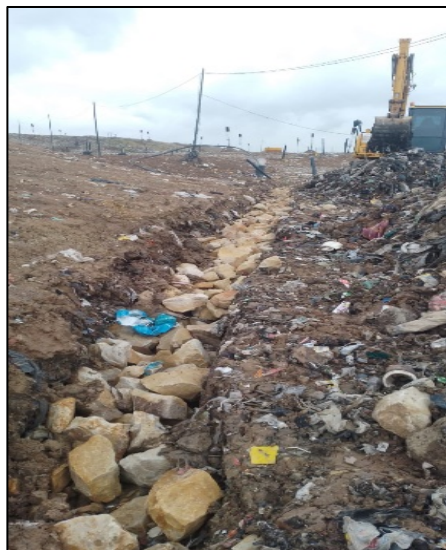
Fotografía 153. Construcción de filtro en piedra rajón de 10" y geotextil no tejido de 119 gr/m2 para corrección de brote de lixiviados en la terraza 1
