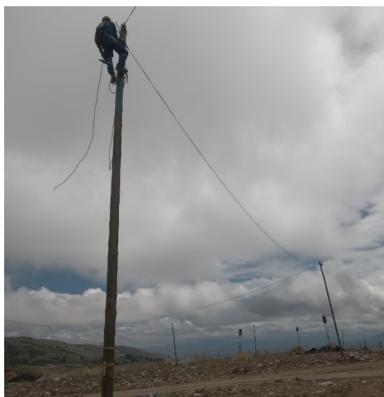
Fotografía 113. Instalación de red de iluminación en vía de salida del frente de disposición
