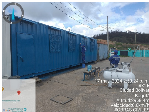
Fotografía 84. Trabajos de pintura interna y externa a contenedores del campamento – Optimización Fase II.
