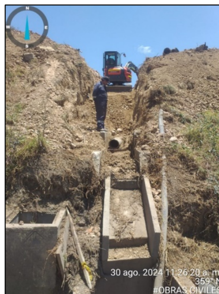
Fotografía 43. Recuperación de canal de aguas lluvias en el sector de Zona IV
