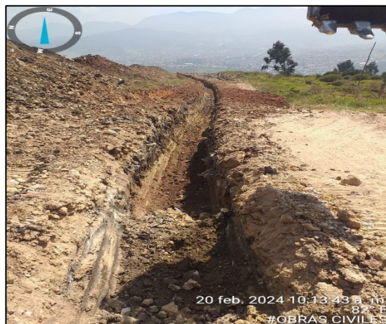
Fotografía 147. Excavación para instalación de tuberías en el sector de Mansión - Biosolidos para corrección de brote de lixiviados
