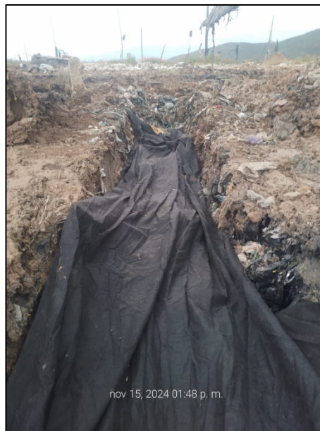
Fotografía 159. Atención brote de lixiviado ID 55 - Pata talud de plataforma VI. (izquierda) y Atención brote de lixiviado ID 68 - Empozamiento en el perímetro del ML 5, 4ª COL. 11. (derecha)
