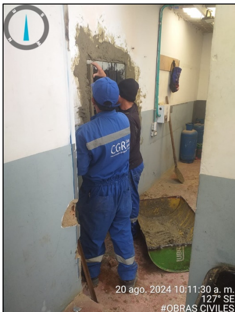
Fotografía 89. Instalación de puerta metálica para acceso a cuarto de almacenamiento - oficina taller temporal (izquierda) y Modificación de descole de drenaje de aguas lluvias en edificio – PTL. (derecha)
