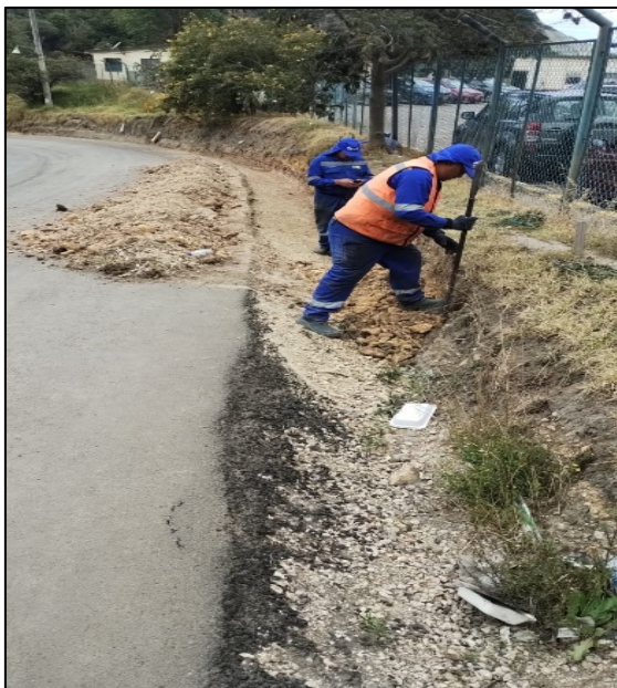
Fotografía 64. Conformación de terreno para construcción de cunetas en el tramo entre las abscisas K2+210 al K2+400 - costado izquierdo (izquierda) y demolición y excavación para reposición de cárcamo de aguas lluvias en la báscula de emergencia (derecha)
