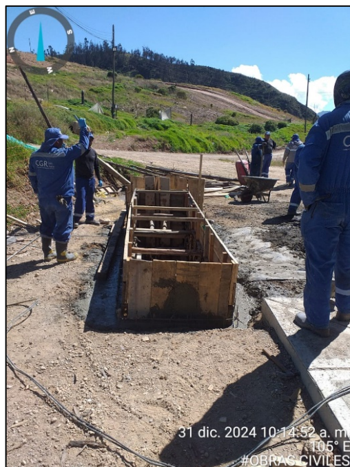
Fotografía 203. Construcción de caja trampa de grasas (izquierda) y construcción de andenes perimetrales pertenecientes al hangar del taller, cárcamo y el cuarto de aceites (derecha)
