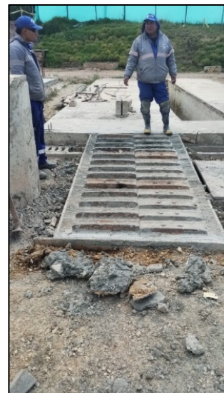
Fotografía 197. Construcción de rampa de acceso al cárcamo de lavado del nuevo taller de maquinaria.
