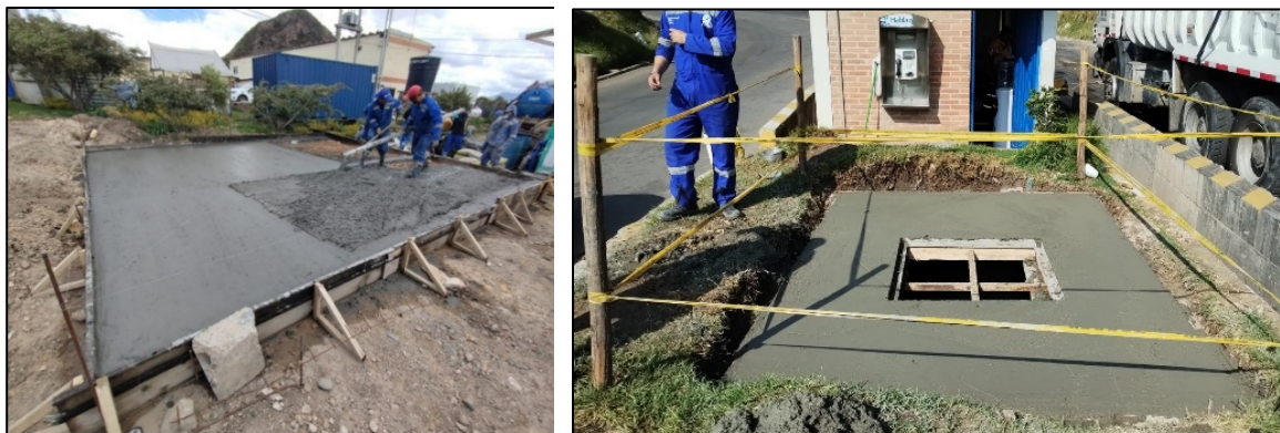
Fotografía 74. Construcción de placa para instalación de estructura prefabricada oficinas – UTIDJ dentro del campamento principal (izquierda) y construcción de tapa en concreto reforzado de pozos sépticos en la báscula de entrada (derecha).
