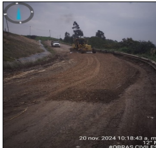
Fotografía 30. Mantenimiento y refuerzo capa de rodadura con material fresado – Portería Principal (izquierda) y refuerzo de capa de rodadura con aplicación de agregado reciclado – Vía alterna sector Zona IV (derecha)
