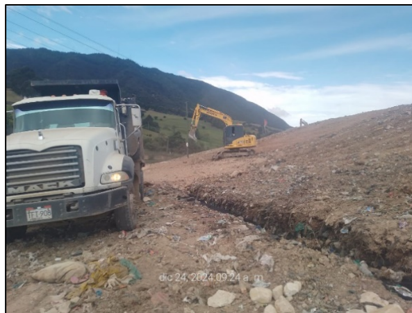
Fotografía 161. Corrección de brotes ID 92. (izquierda) y corrección brote de lixiviado ID 84. (derecha)
