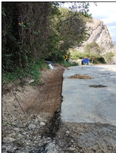
Fotografía 53. Construcción de cunetas perimetrales en concreto reforzado en el tramo entre las abscisas K2+150 y K2+205 costado derecho
