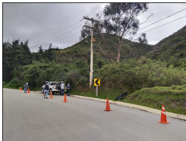
Fotografía 109. Cambio de corta circuitos completos (incluyendo cañuelas) y cables secundarios perteneciente a red de media tensión en transformador bifásico ubicado en el poste 33 – vía principal
