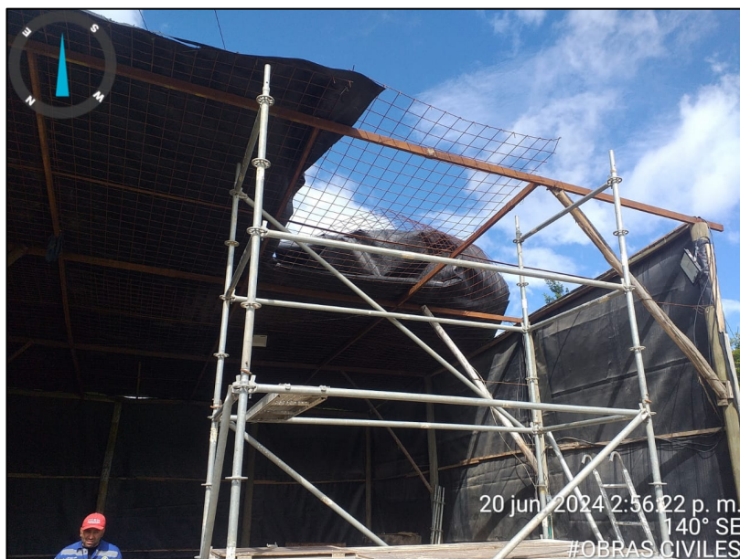
Fotografía 86. Desmonte de cubierta de hangar, taller provisional ubicado en Zona 1 Área 2.
