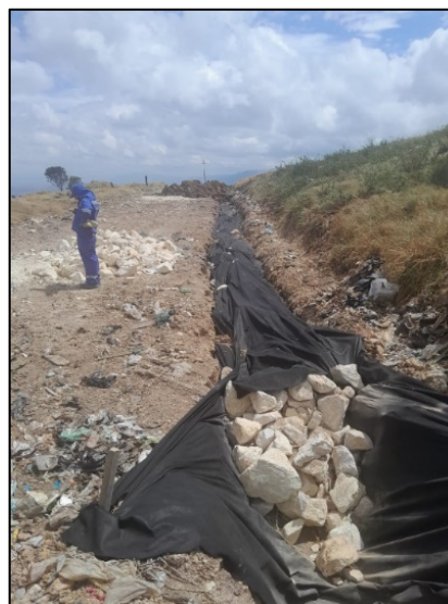
Fotografía 169. Adecuación de filtros de cierre - Zona de Optimización Fase I.
