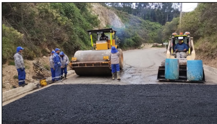
Fotografía 68. Construcción de dos reductores de velocidad en el sector aledaño al campamento principal (Izquierda) e Instalación de tubería de descole perteneciente al cárcamo de aguas lluvias - Basculas de salida (derecha)
