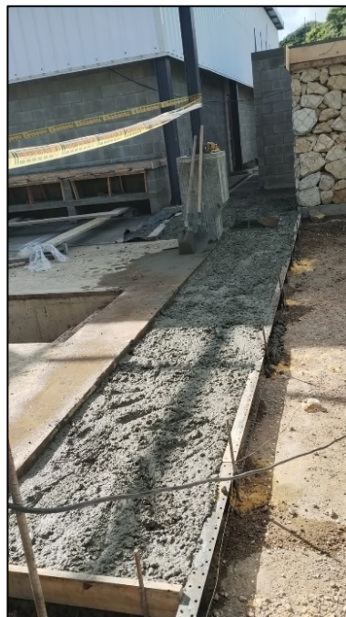
Fotografía 203. Construcción de caja trampa de grasas (izquierda) y construcción de andenes perimetrales pertenecientes al hangar del taller, cárcamo y el cuarto de aceites (derecha)
