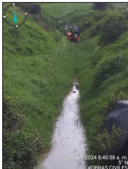
Fotografía 40. Limpieza de cuneta de agua lluvia con miniexcavadora – Zona IV
