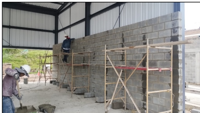
Fotografía 199. Instalación de groutin de nivelación en las bases de las columnas metálicas. (Izquierda) e Instalación de la mampostería perimetral del hangar. (derecha)
