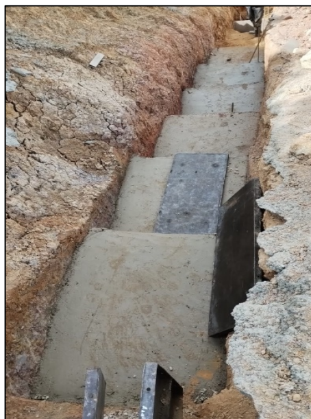
Fotografía 211. Construcción de disipadores de energía – Descenso de berma 3 a berma 2 - talud “Poste 53”
