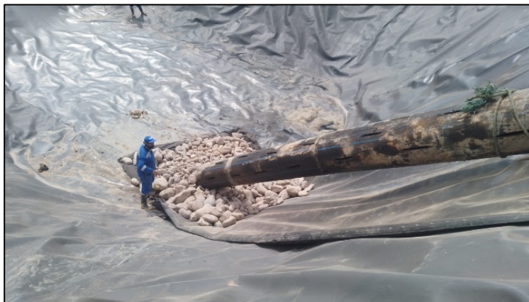
Fotografía 162. Mantenimiento y cambio de geomembrana de pondaje temporal foso taller
