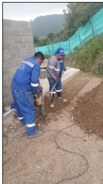
Fotografía 202. Construcción de mesones en concreto reforzado en el hangar del taller de maquinaria (izquierda) y Nivelación y replanteo para la construcción de andenes perimetrales al área del hangar del taller de maquinaria (derecha)
