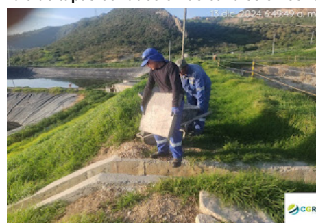
Cambio de tapas conducción de canales en concreto
