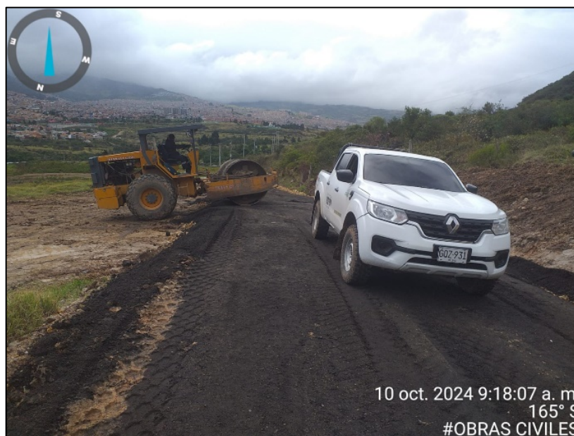
Fotografía 229. Instalación de material fresado de carpeta asfáltica - Celda VI
