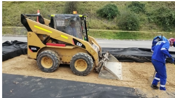
Fotografía 61. Excavación para arreglo de fallo ubicado en el carril de salida de la abscisa K1+330 (izquierda) y Compactación de base granular en reparación de pavimento en calidad de garantía sobre la abscisa K1+330 (derecha)
