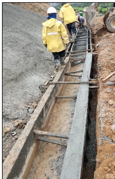
Fotografía 209. Construcción de cunetas en concreto reforzado con fibras de polipropileno. – berma 1 - talud “Poste 53”
