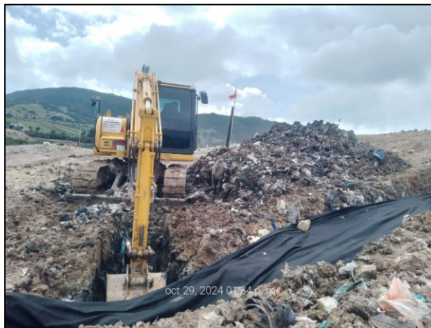
Fotografía 157. Atención brote de lixiviado ID 66 – Frente a Dique ambiental sur (izquierda) y corrección de Brote de lixiviado nuevo – CH542 (derecha)
