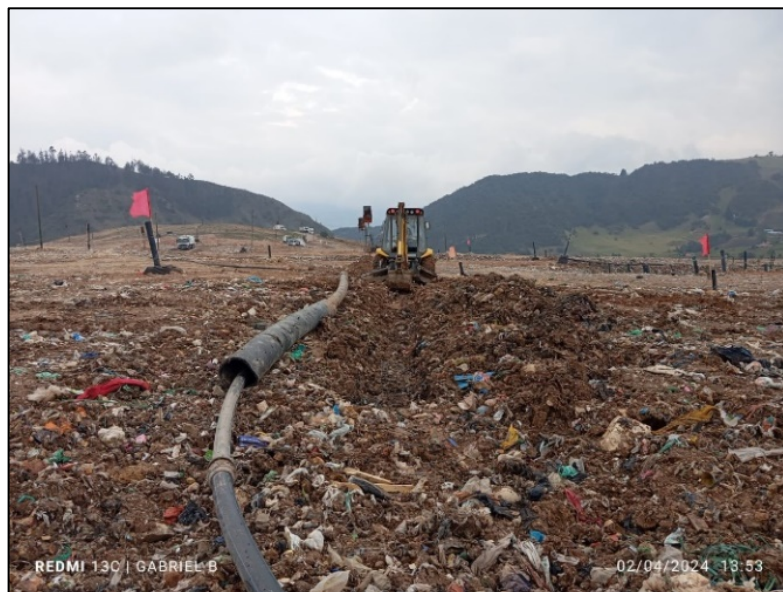
Fotografía 135. Instalación de pasante para mangueras de lixiviado en terraza 1 (Izquierda) y extracción de bomba sumergible para mantenimiento (derecha)
