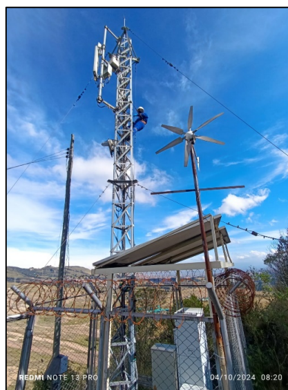
Fotografía 117. Instalación de postes de madera y cableado en 110v para alimentación de impulsor de cerca eléctrica instalada en el cerramiento perimetral (izquierda) y Mantenimiento de equipos en antena Juana 2 (derecha)
