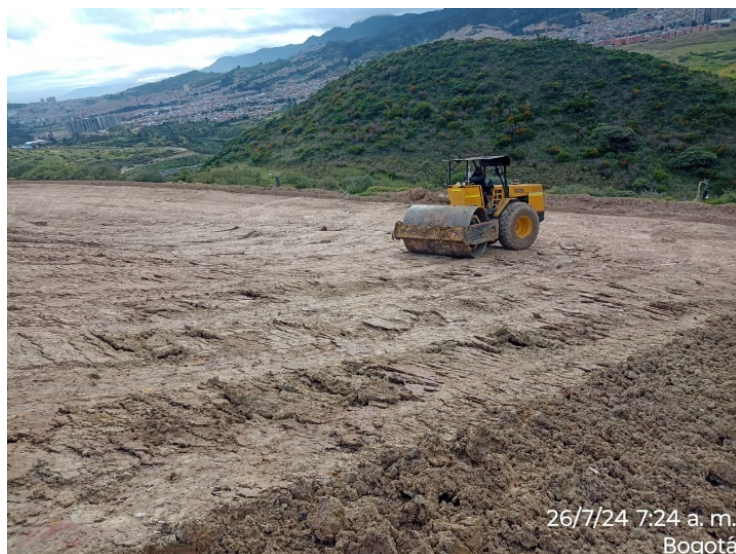
Fotografía 178. Compactación de complemento de capa de arcilla en Zona II - Área 2
