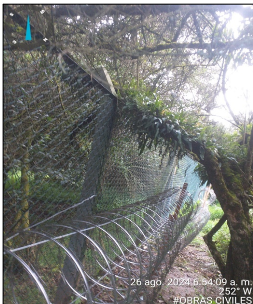
Fotografía 127. Instalación de concertina en cerramiento perimetral del tramo del dique VI
