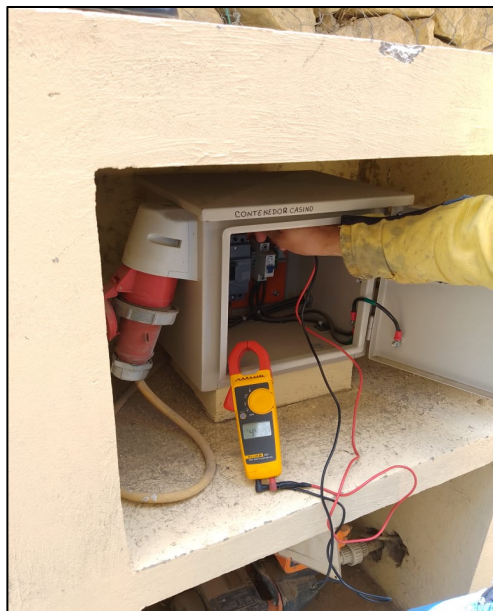
Fotografía 104. Revisión y corrección en fallas del circuito eléctrico en las instalaciones de campamento principal
