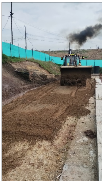
Fotografía 194. Nivelación de rasante con recebo (Izquierda) e instalación de columnas con postes de madera inmunizados para hangar adicional de mantenimiento (derecha)
