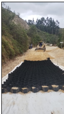
Fotografía 54. Instalación de geocelda en el K2+437 hasta el K2+460 en ambos costados.
