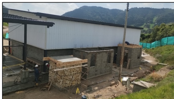
Fotografía 204. Construcción de gaviones con placa en concreto reforzado para instalación de tanque de almacenamiento elevado (Izquierda) y Construcción de vigas de amarre y placa cubierta en el cuarto eléctrico y compresores (Izquierda)
