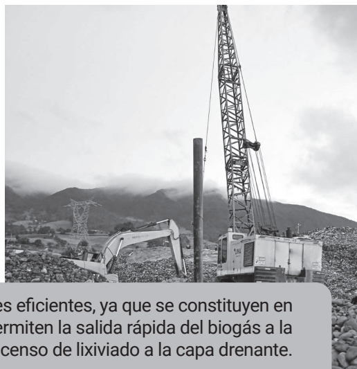
» 3. Chimeneas perforadas (verticales), las cuales mediante la introducción de una bomba se extrae el lixiviado presente en las zonas de altas presiones.
