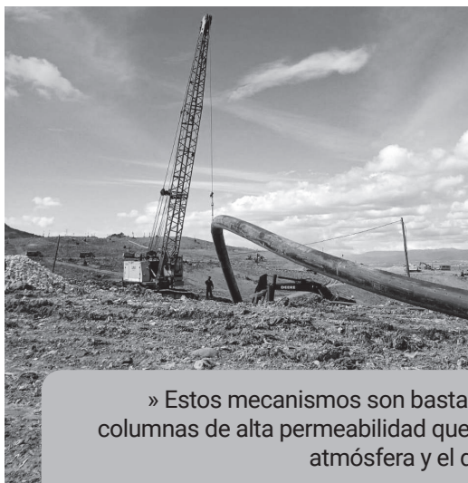
» 2. Perforaciones dirigidas, extrayendo mayor volumen de lixiviado.
